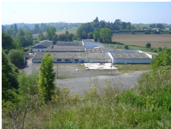
Vue depuis le coteau
