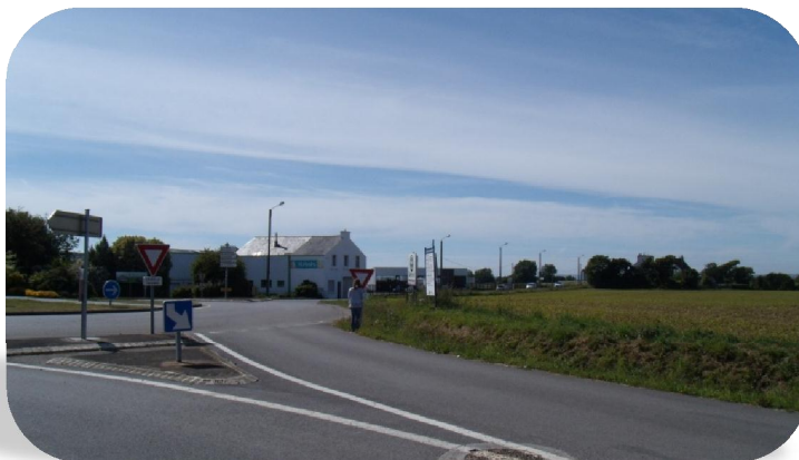
Photographie 2: Un aménagement à prévoir pour les piétons Source : Aline Bourdais
