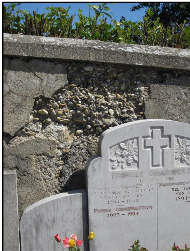
Figure 15 : Exemple de dégradation du mur d'enceinte
