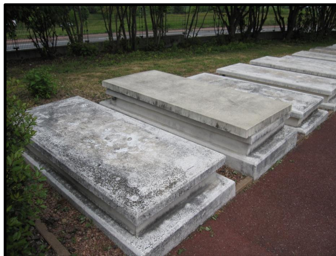
Figure 43 : Exemple de caveaux préfabriqués, cimetière de Corbas (69)
