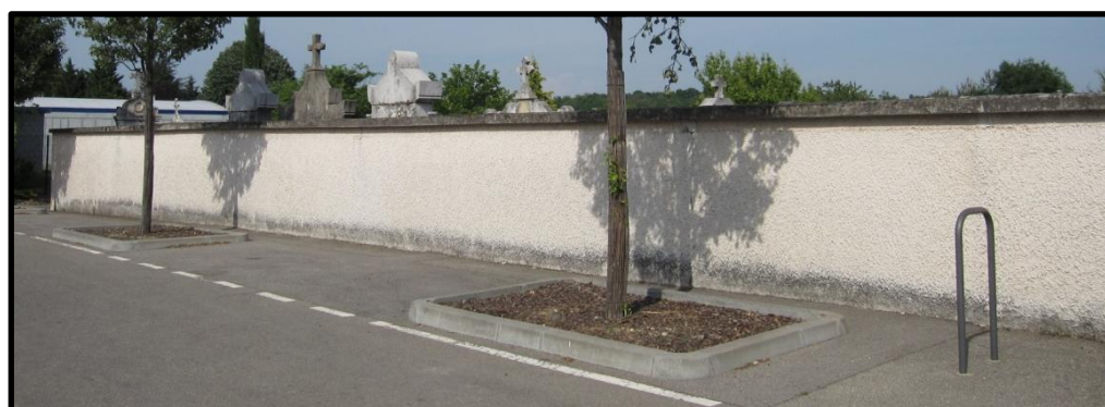
Figure 13 : Mur d'enceinte du cimetière
