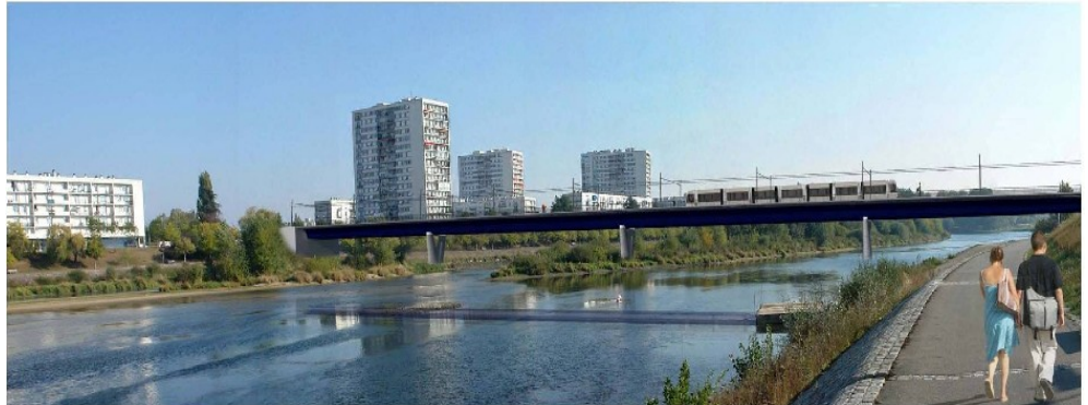
Photo 12: futur pont sur le Cher
