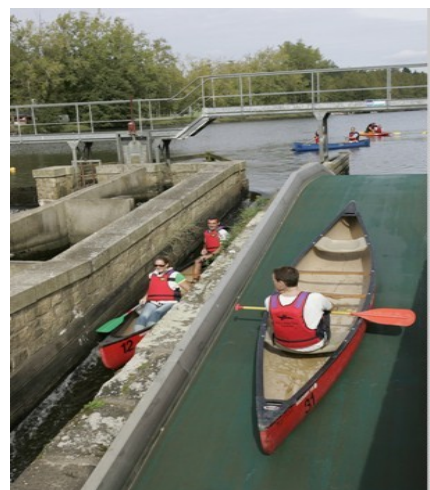
Photo 42: Exemple de tapis roulant pour canoë-kayak Source: hydrostadium.com
