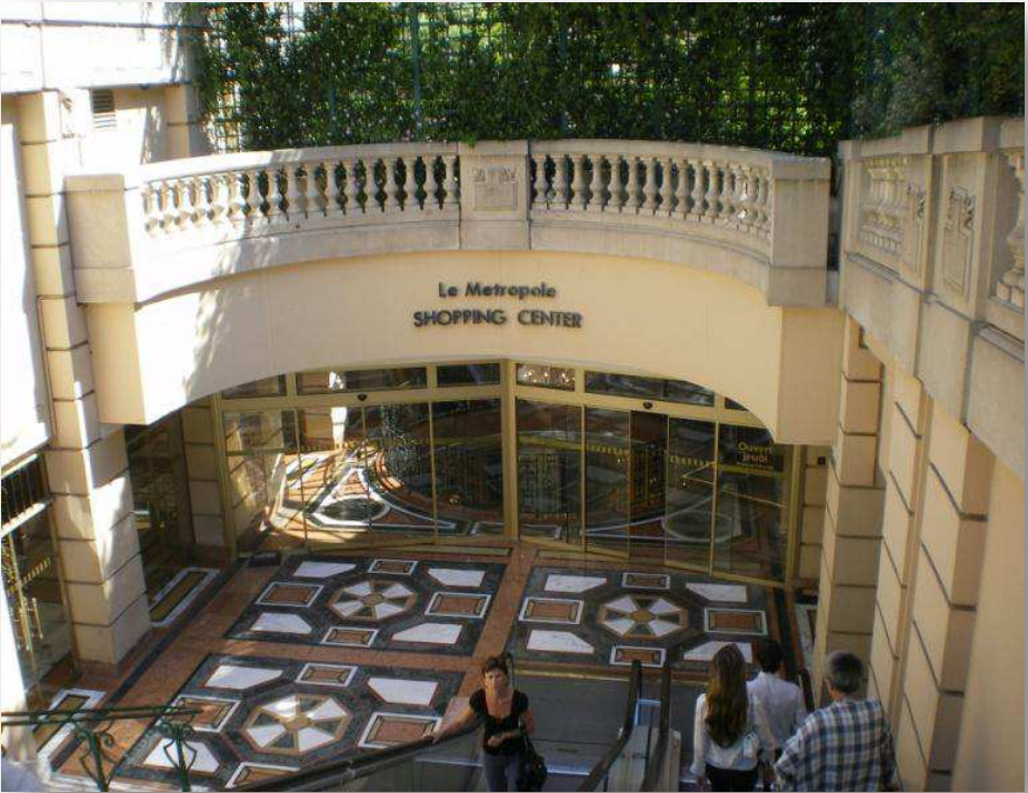
Photographie 250: Centre commercial Le Métropole
