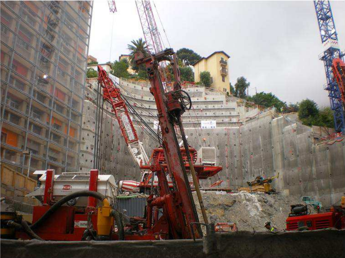
Photographie 2: Chantier de la tour Odéon - Mai 2011
