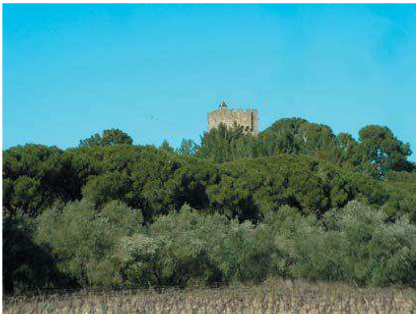
Photo 66 : tour Montrabech (source PLU)
