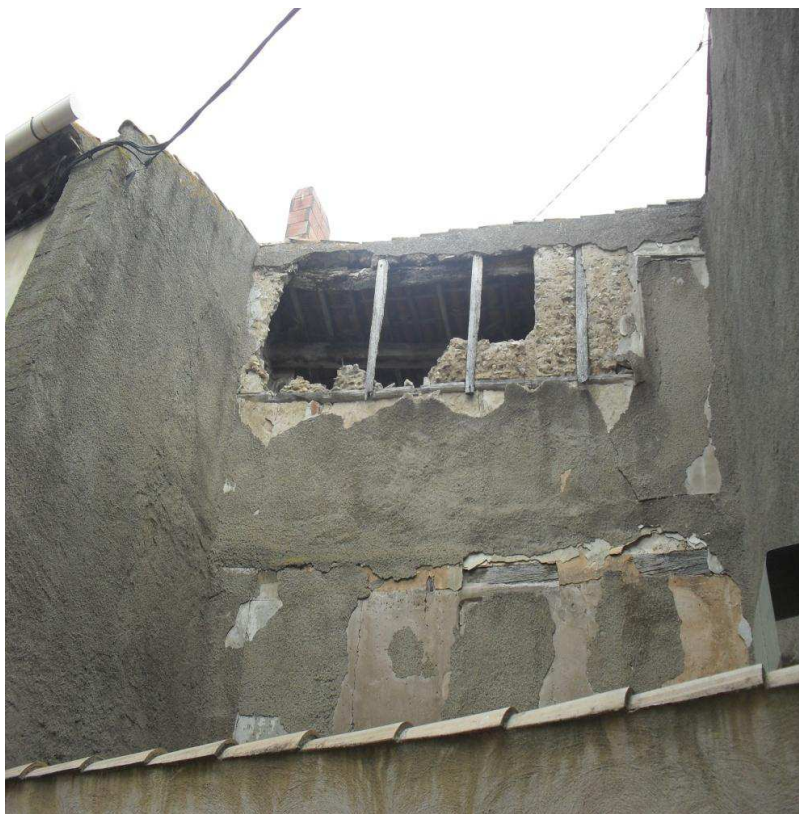
Photo 22 : photo de l'arrière de la maison de ville de la rue St Just sous dossier MOUS (réalisation personnelle)
