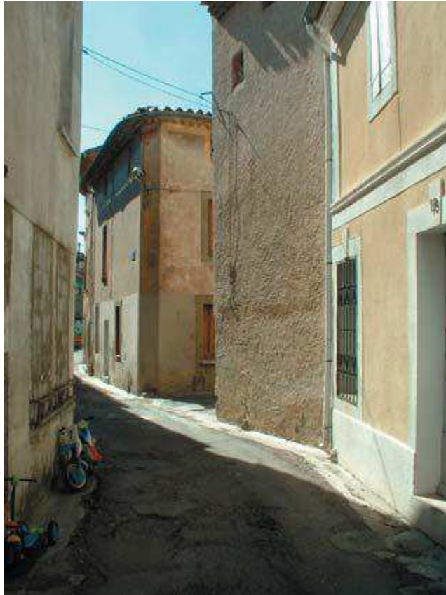
Photo 40 : Un réseau communal étroit en centre ancien mais le plus souvent bien entretenu (source PLU)
