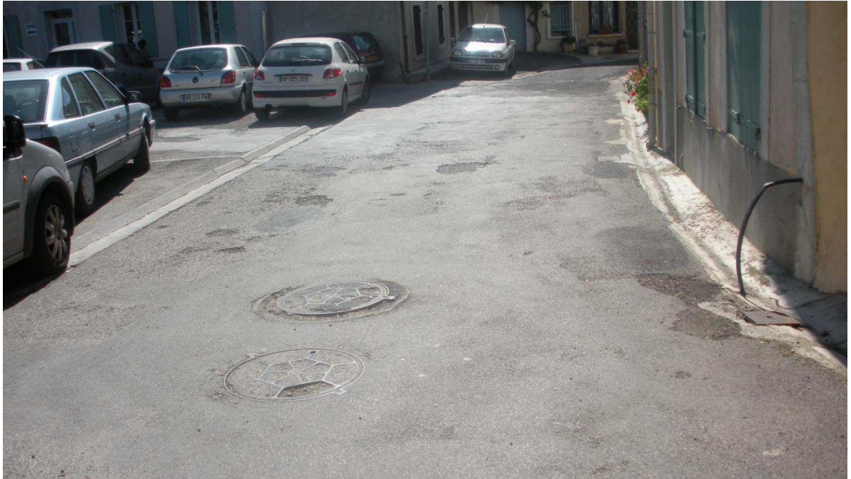
Photo 69 voie Emile Cabrié
