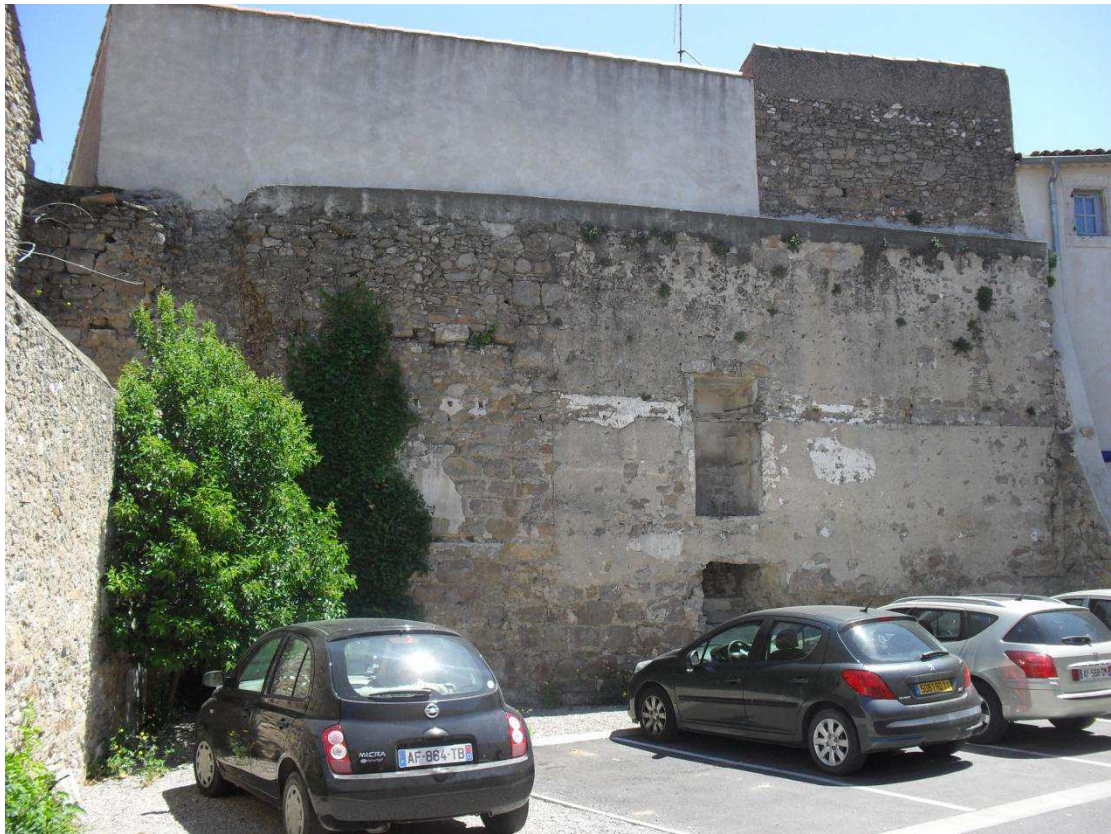
Photo 6 : ancien mur d'enceinte localisé au Sud-est du centre-bourg (réalisation personnelle)
