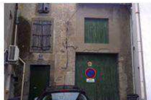
Photo 86 : impasse rue St Just (réalisation personnelle)
