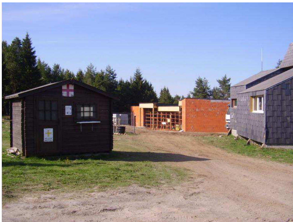
Photo 13 : Travaux du site de Pessade
