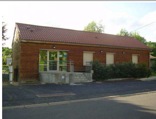
Photo 12 : Structure multi-accueil de Rouillas Bas Réalisation personnelle
