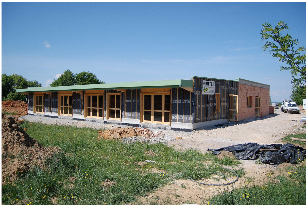
Figure 39 : Chantier de construction d'un bâtiment public avec bois partiellement apparent – Futur accueil de loisir de la CC au Vert Plateau
