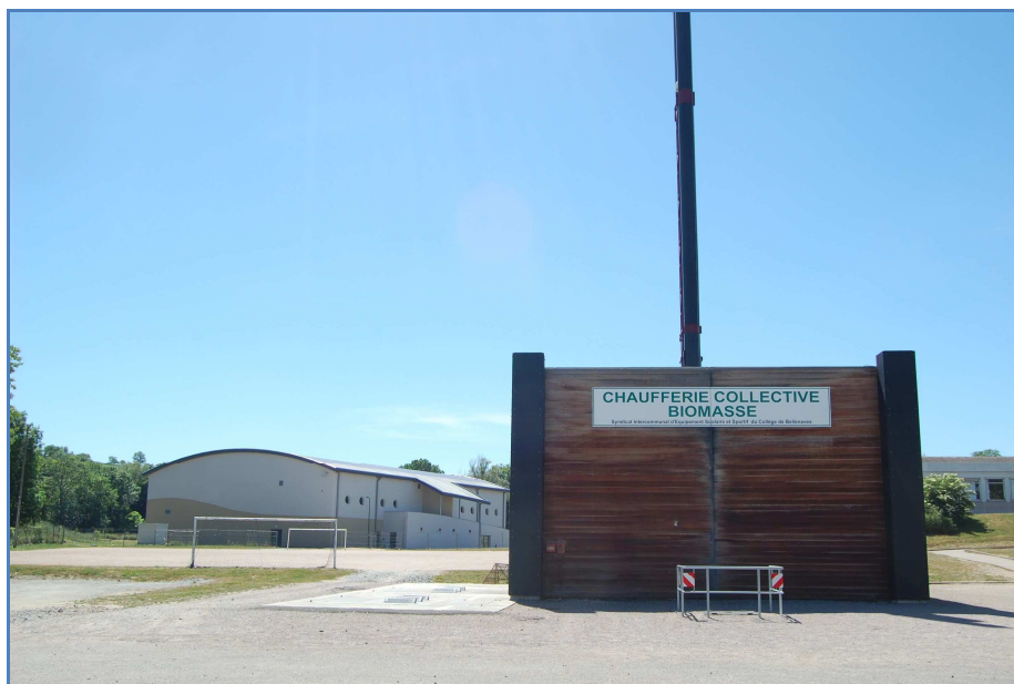
Figure 35 : Chaufferie collective biomasse de Bellenaves. En arrière-plan, le collège et le gymnase alimentés.
