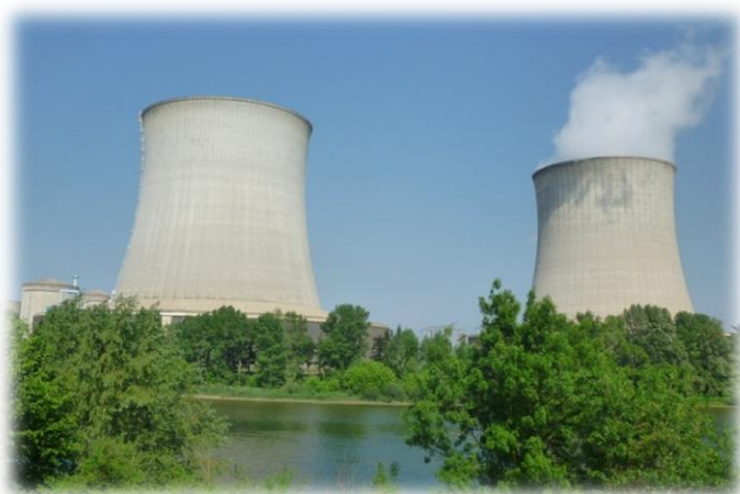
Photo 24 : Centrale nucléaire de Saint-Laurent-des-Eaux Réalisation Lucie GRENIER
