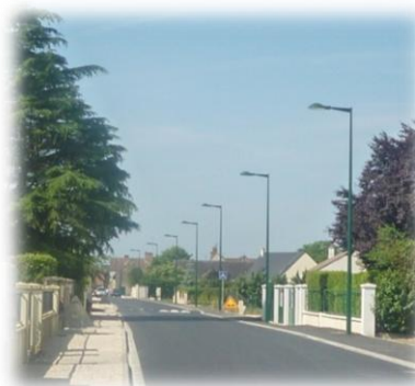
Photo 129 : Rue de l'Argenterie à Saint-Claude-de-Diray Réalisation Loïc BASSET
