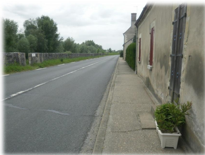
Photo CLIX : Départementale D952 longeant la commune de Veuves - Réalisation Lucie GRENIER
