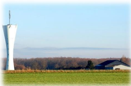
Photo 87 : Château d'eau de Tillières-sur-Avre (27) Source : cartesfrance.fr
