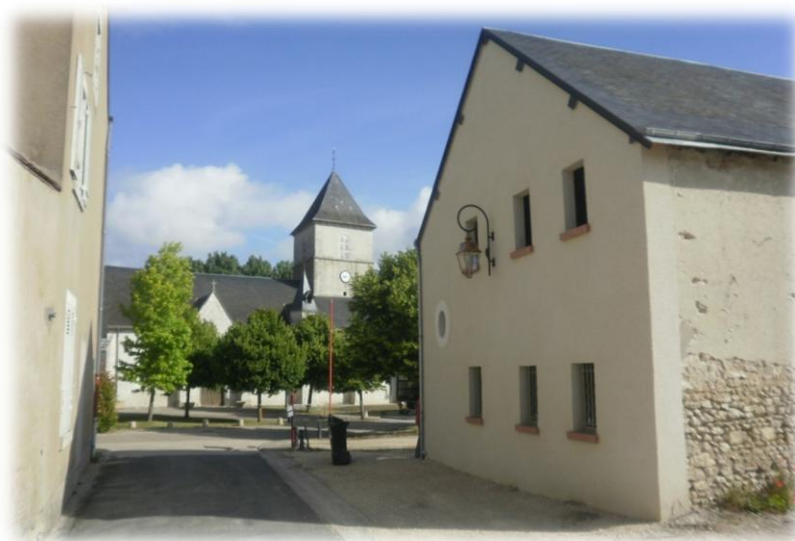
Photo CXC : Ancienne église à Huisseau-sur-Cosson - Réalisation Loïc BASSET
