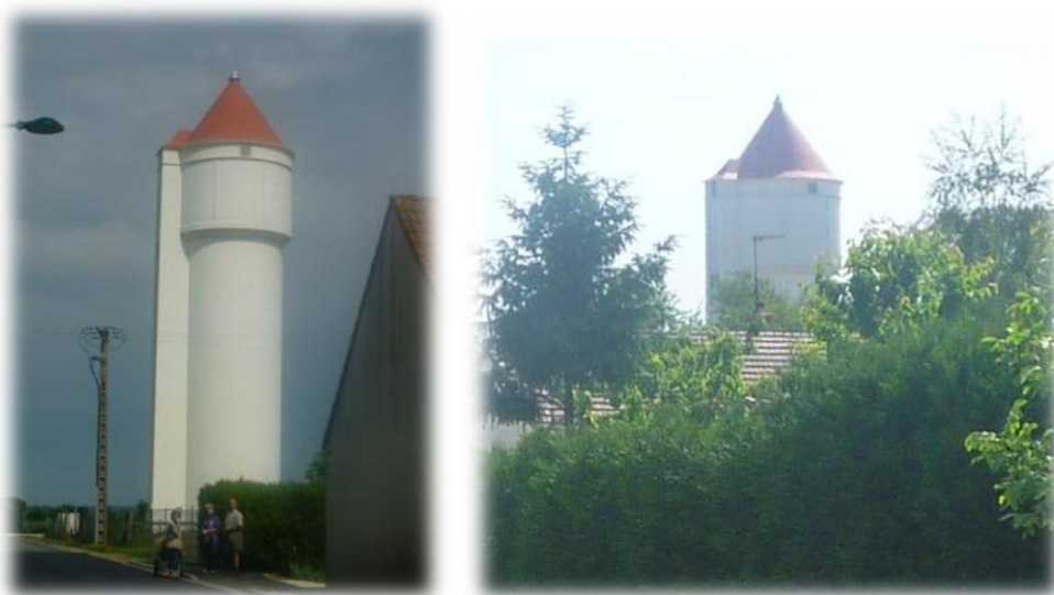
Photo 83 : Château d'eau de Saint-Claude-de-Diray Réalisation Lucie GRENIER
