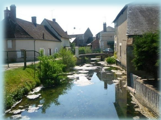
Photo 139 : Aménagements autour des cours d'eau, à gauche Monteaux et à droite Chouzy-sur-Cisse
