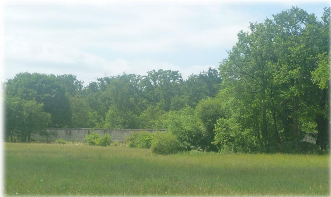
Photo CLXXXI : Mur de Chambord envahi par une végétation non entretenue, Thoury Réalisation Lucie GRENIER
