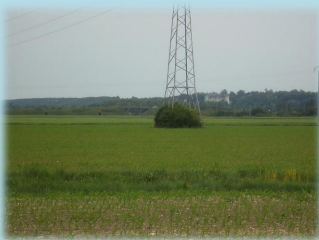
Photo 123 : Vue du Château de Chaumont-sur-Loire Réalisation Jonathan GRAND
