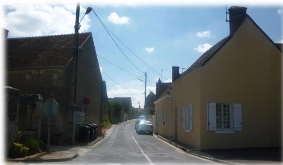
Photo 61 : Maison réhabilitée avec un crépi non traditionnel à Huisseau-sur-Cosson Réalisation Jonathan GRAND
