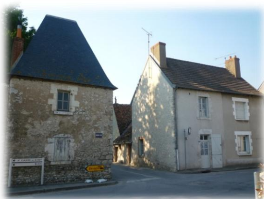
Photo 63 : Réhabilitation maladroite d'une façade à Montlivault Réalisation Loïc BASSET
