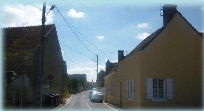
Photo CXLIII : Rénovation maladroite à la Chaussée-le-Comte - Réalisation Florian CARDARELLY
