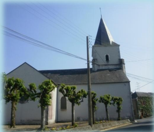
Photo 136 : Lignes électriques aux abords de l'église de Courbouzon - Réalisation Lucie GRENIER
