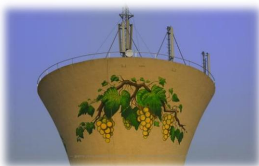
Photo 86 : Château d'eau de Tillières (44) Source : pierre.yves.aupied.free.fr
