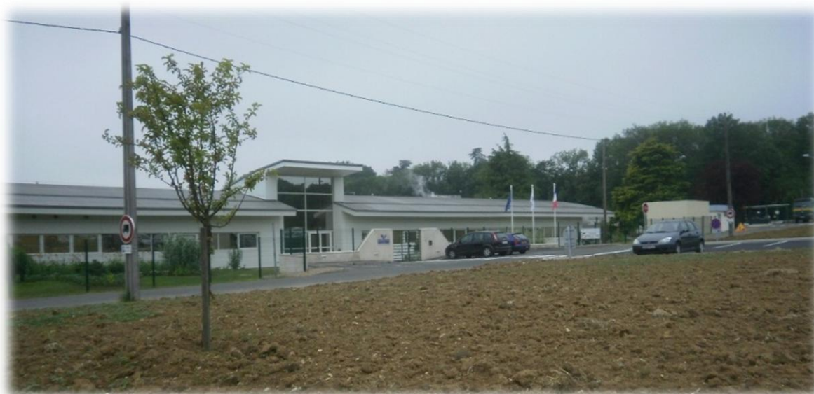
Photo CLXVII : Entrée Est de Chouzy-sur-Cisse, laboratoire pharmaceutique Réalisation Lucie GRENIER
