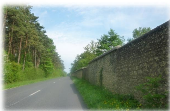
Photo 31 : Mur du Domaine de Chambord Réalisation Lucie GRENIER
