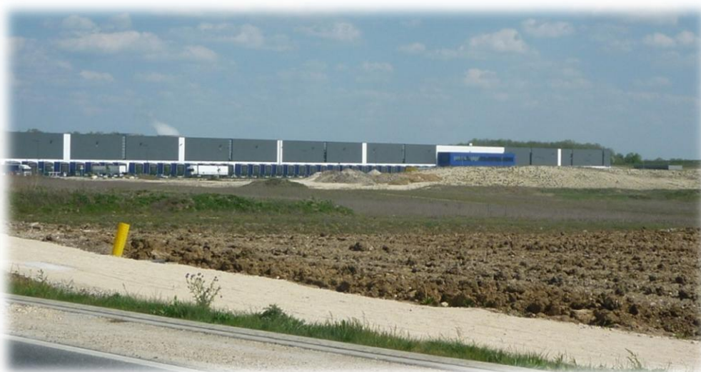
Photo 27 : Les Portes de Chambord I à Mer Réalisation Loïc BASSET
