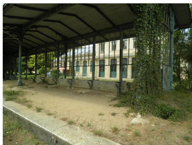
Photographie 35 : Vue sur la gare depuis le panneau d'interprétation
