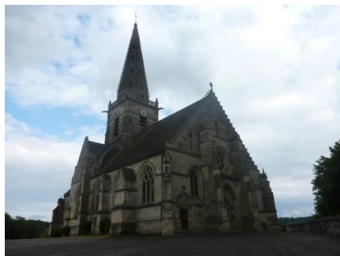
Photographie 124 : Eglise d'Autrêches Source : Photographie personnelle
