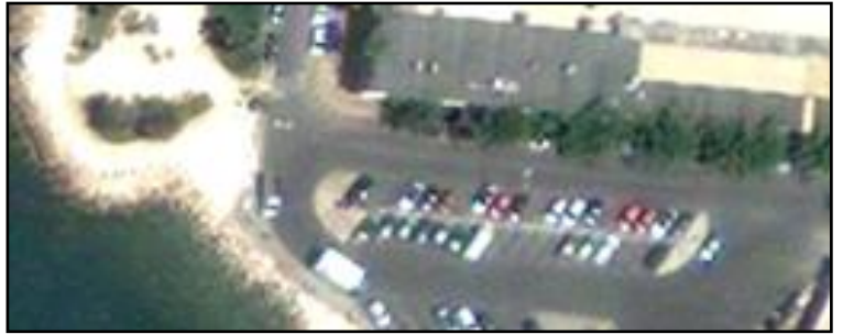
Figure 37: Vue aérienne du parking du port marchand au nord du site Source Google Earth
