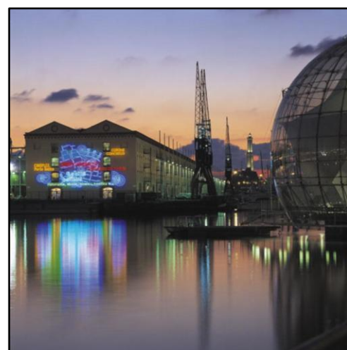
Figure 49: Anciens docks Source site officiel du port
