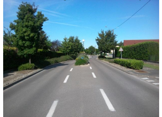
Photo 24: Les aménagements routiers à Marcilly
