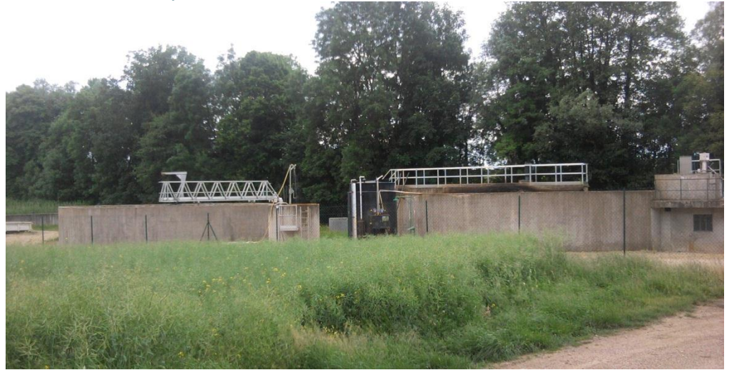
Photo 32: La station d'épuration
