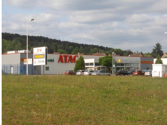
Photo 14: Le supermarché ATAC, dans la zone commerciale
