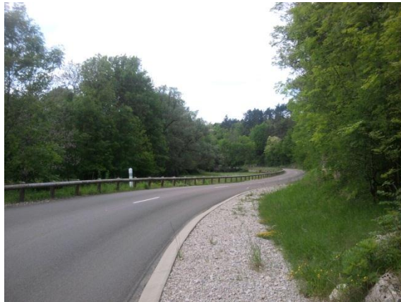
Photo 2: La vallée de la Venelle, avant l'entrée dans Selongey
