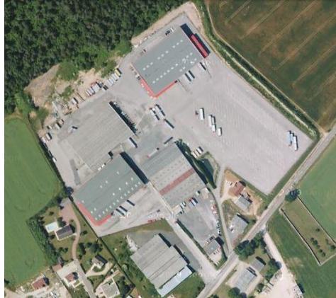
Photo 23: Vue aérienne sur les transports Cordier
