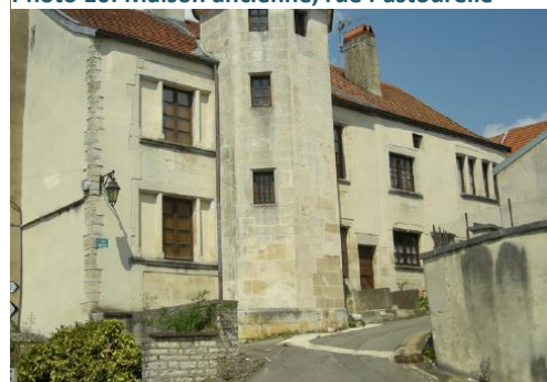
Photo 10: Maison ancienne, rue Pastourelle
