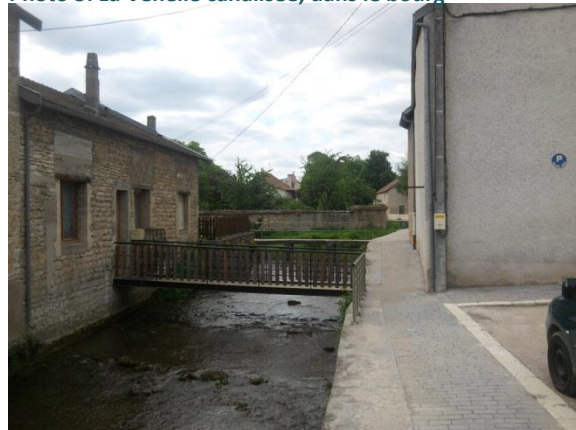
Photo 3: La Venelle canalisée, dans le bourg
