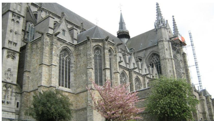
Photographie 4 : Collégiale Sainte-Waudru (rénovation de la façade) Source : A. Morfin
