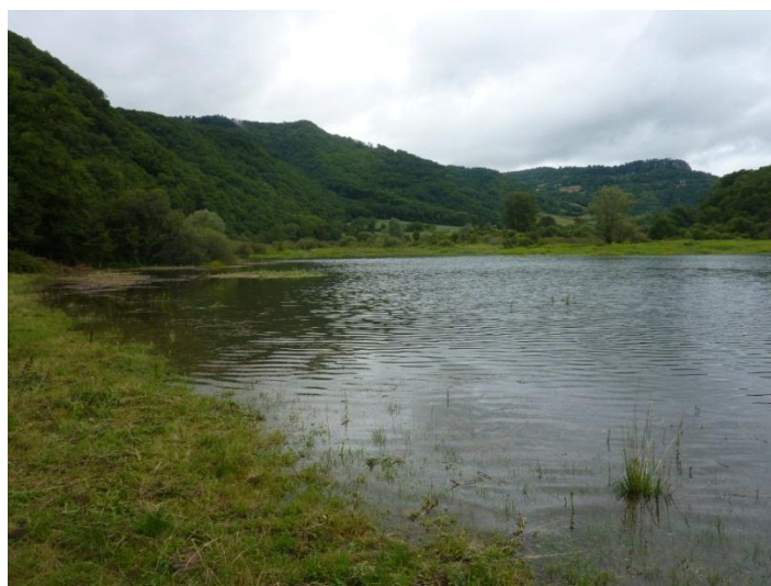
Figure 20 : Barrage de Marèges au niveau de Madic le 19 juillet 2011. La Côte de Marèges lors de cette sortie était de 414,5 m NGF. (Source : Photographie personnelle)
