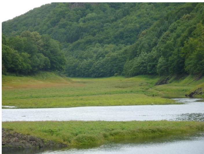
Figure 17 : Barrage de Bort les Orgues au niveau du pont d'Arpiat le 19 juillet 2011. La côte de Bort les Orgues lors de cette sortie était de 527.8 mNGF. (Source : photographie personnelle)
