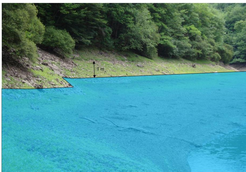
Figure 25 : Vue de la zone de reproduction potentielle noyée grâce à la gestion du niveau d'eau par un batardeau. (Source : photographie personnelle modifiée)
