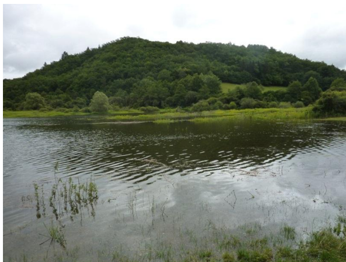
Figure 21 : Barrage de Marèges au niveau de Madic le 19 juillet 2011. La Côte de Marèges lors de cette sortie était de 414,5 m NGF. (Source : Photographie personnelle)
