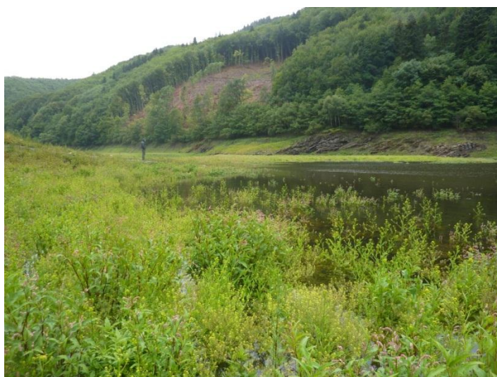
Figure 18 : Barrage de Bort les Orgues au niveau du pont d'Arpiat le 19 juillet 2011. La côte de Bort les Orgues lors de cette sortie était de 527.8 mNGF. (Source : photographie personnelle)
