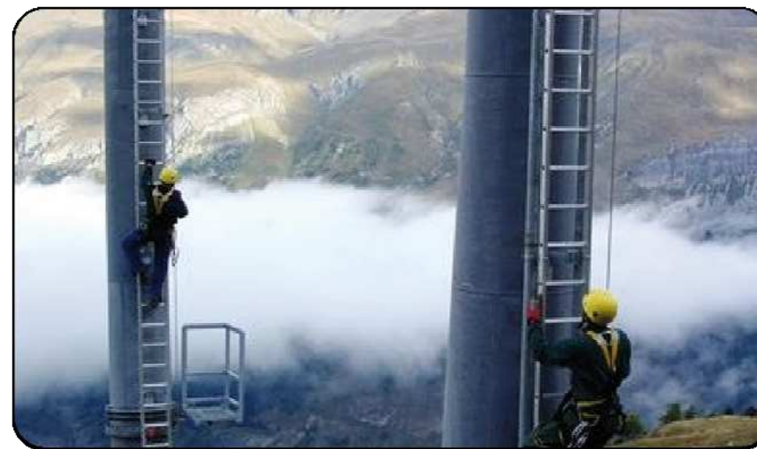
Figure 107: Maintenance d'une remontée mécanique, Source: www.btsmaintenance.fr
