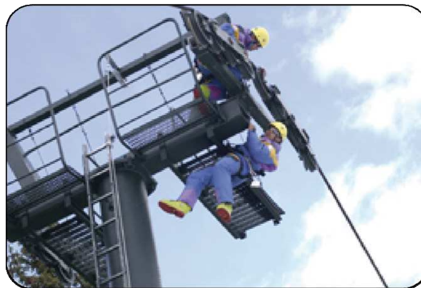
Figure 98: Maintenance d'une remontée mécanique Source: www.ac-grenoble.fr
