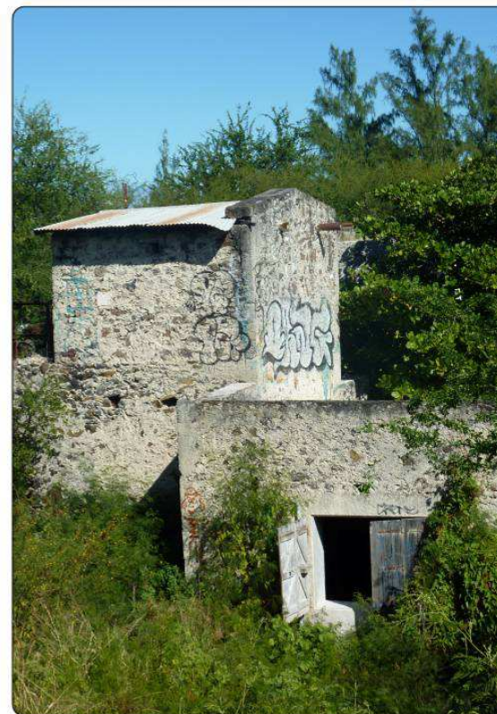
Figure 122: Le four à chaux Méralikan, Auteur : Juliette Berger
