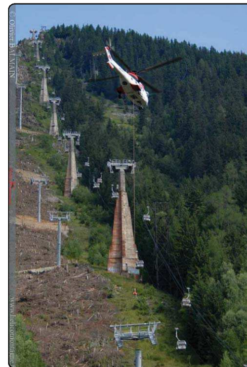
Figure 96: Hélicoptère servant à l'implantation des pylônes, Source: www.helicomontagne.fr
