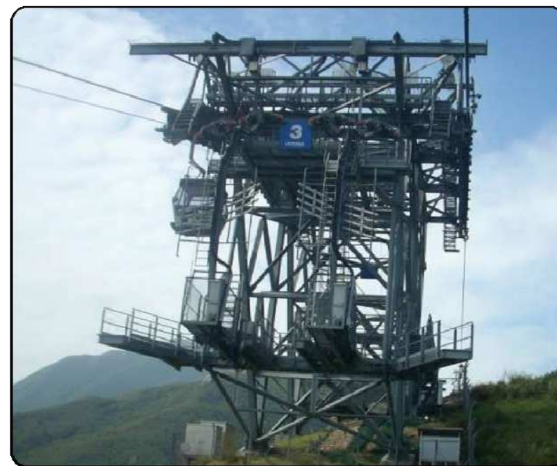
Figure 67: Pylône contenant deux nacelles de sauvetage, Hong-Kong, Chine,
