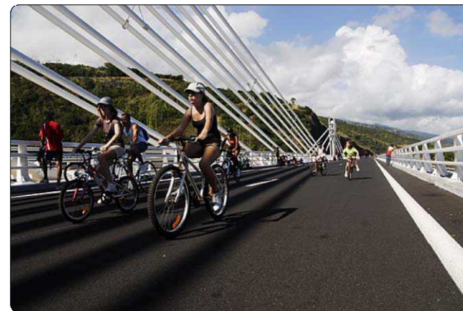
Figure 13: La route des Tamarins avant sa mise en circulation, Source : http://www.temoignages.re
