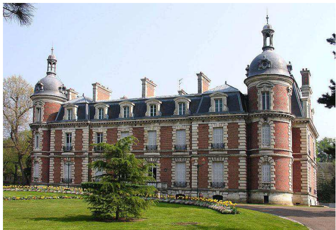
Photographie 8 : Le château de Trousse-Barrière Source: wikipedia.org
