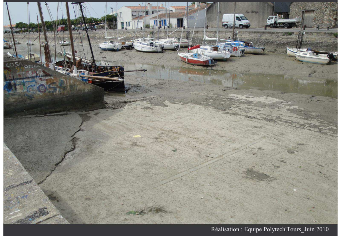
PHOTOGRAPHIE - L'AIRE DE CARENAGE
