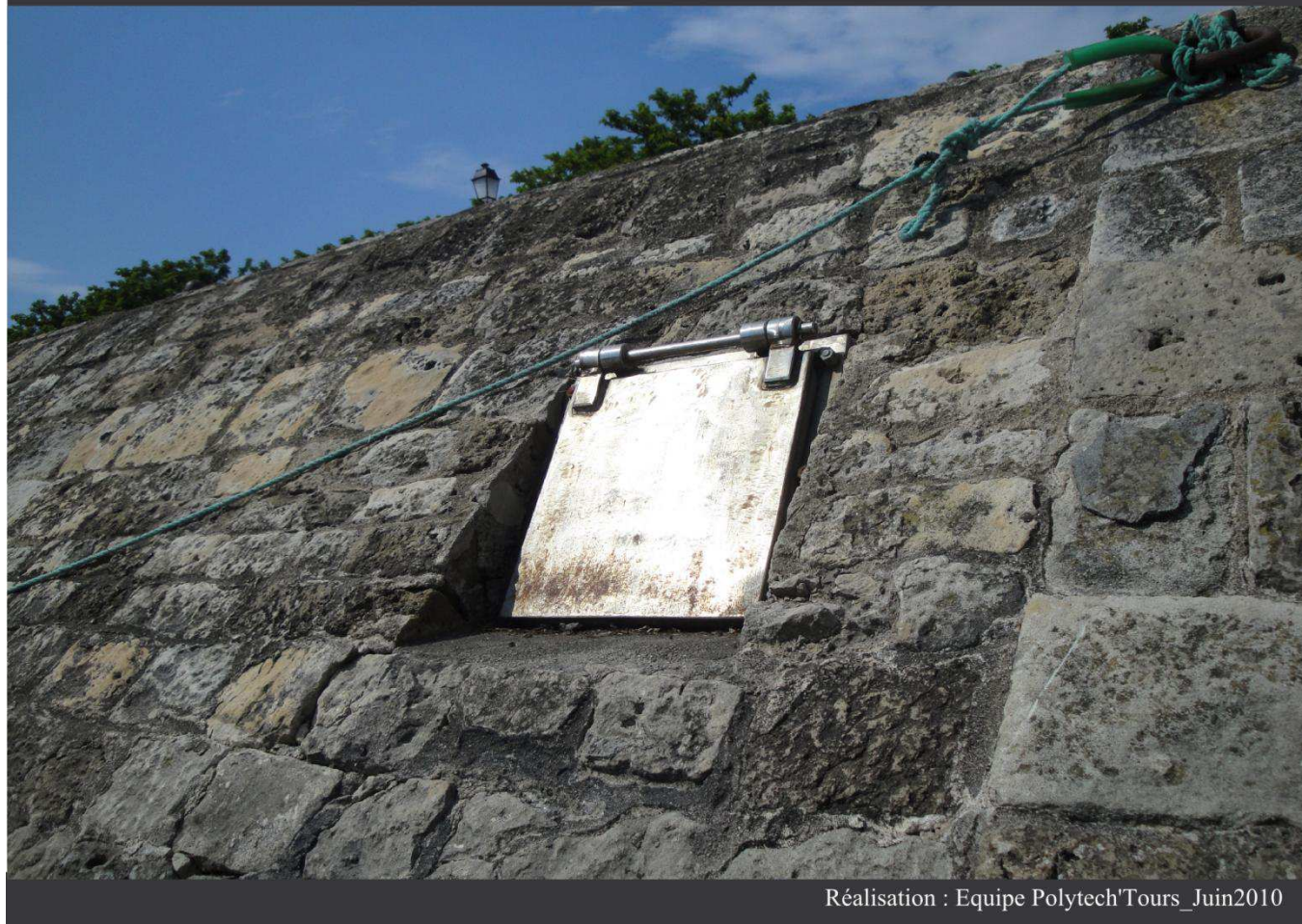
PHOTOGRAPHIE - UN CLAPET LE LONG DU QUAI
