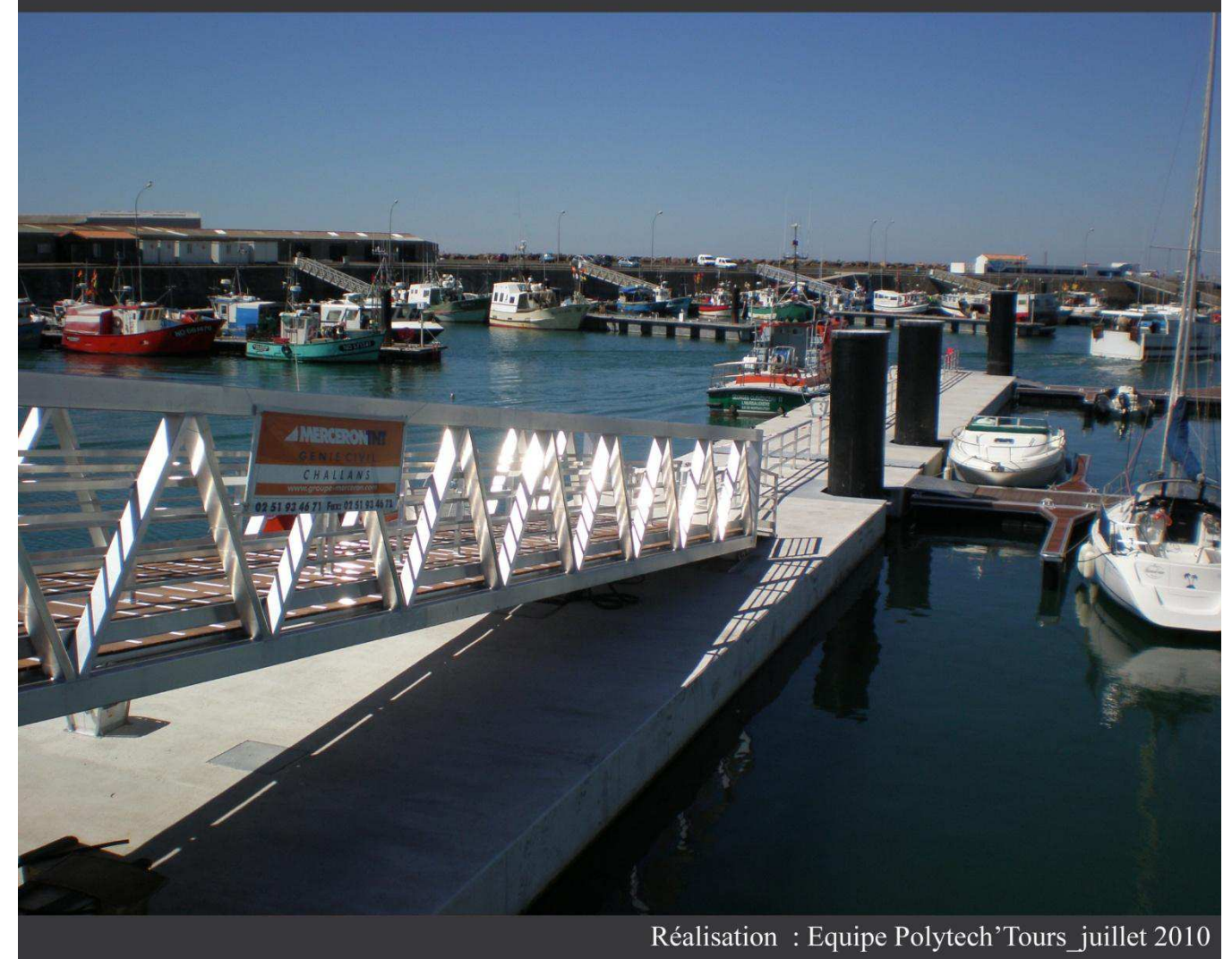
PHOTOGRAPHIE - LE PONTON SEMI-FLOTTANT EN BETON DE L'HERBAUDIERE
