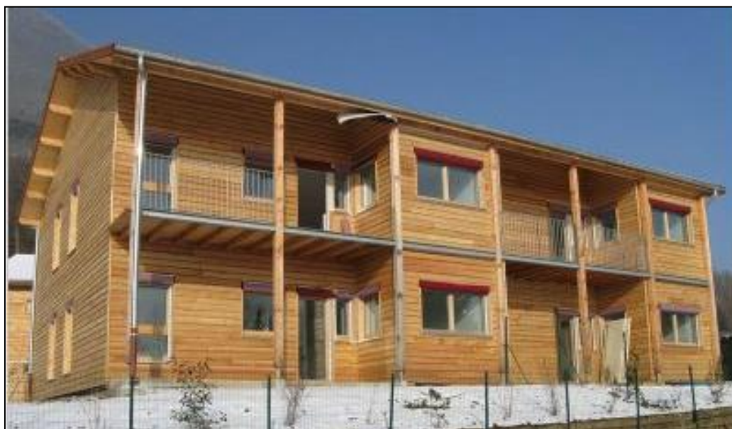
Figure 46: Logement collectif en Isère en ossature bois
