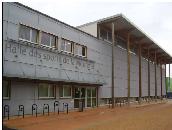
Photo 4 : La halle des sports (source : photo de Julie Rodriguez)
