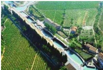
Figure 22 : Les écluses de Fonserannes
