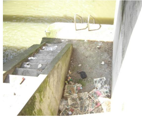
Figure 53 : Pollutions visuelles et olfactives au niveau de l'écluse Bayard
