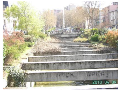
Figure 35 : Vue de l'extrémité du tronçon intermédiaire situé sur le pont de la rue Bayard
