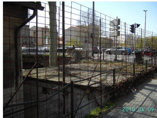
Figure 65 : La clôture entoure les deux bâtiments afin d'éviter leur occupation
