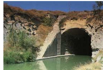
Figure 24 : Le tunnel de Malpas
