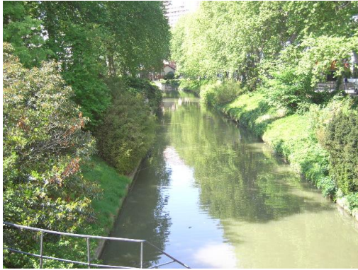
Figure 38 : Vue du point de départ de la troisième jonction
