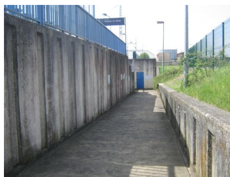
Photographie 11 : Entrée du passage souterrain de la gare Prise par Emeline Prévot
