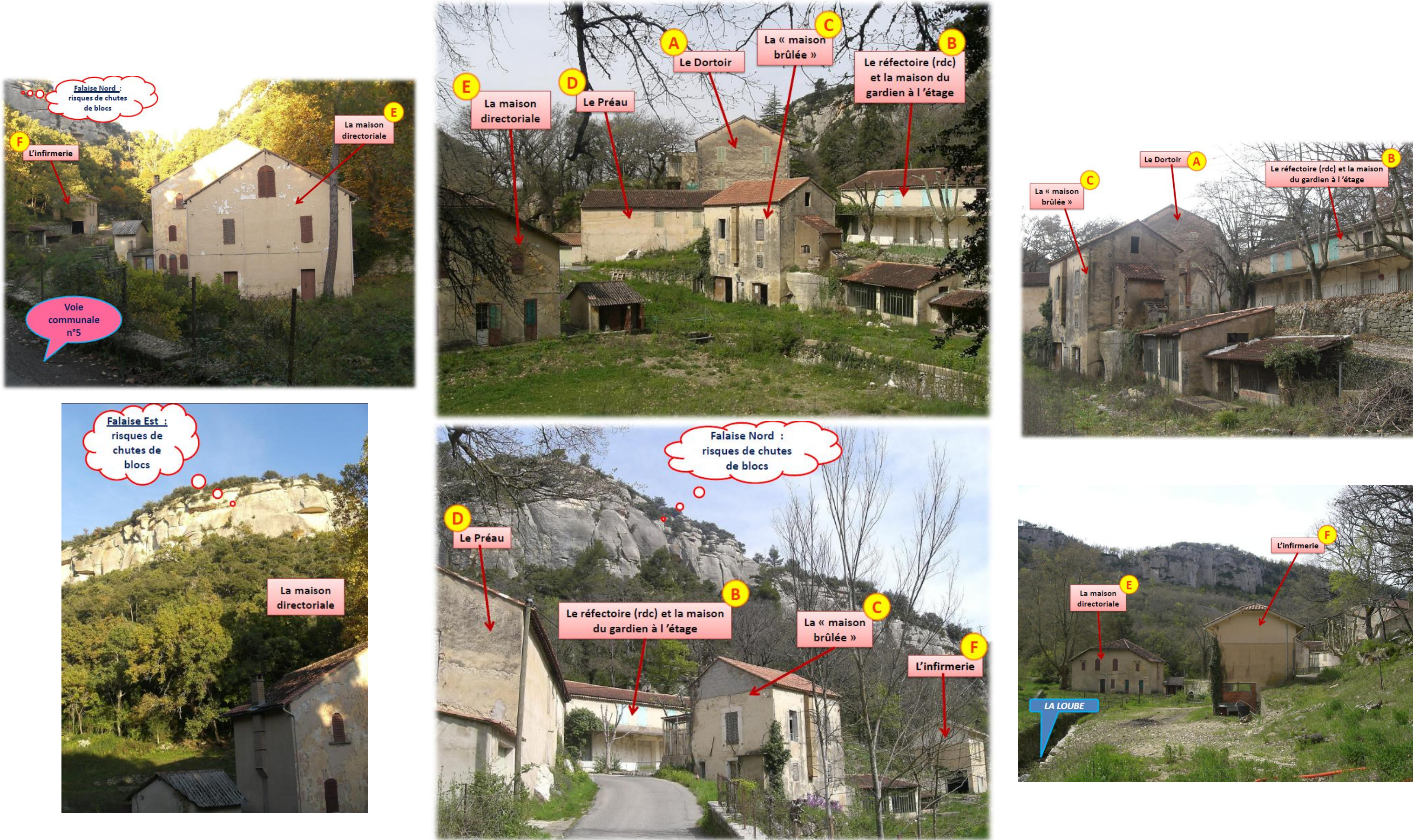
Figure 34 : Vues d'ensemble du site de la Tuilière
