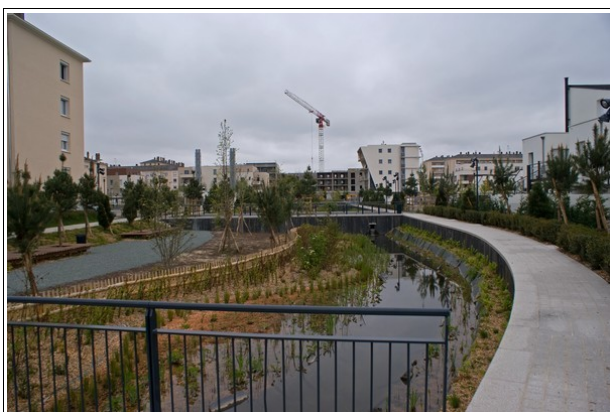
Illustration 7: Opération de renouvellement urbain dans le quartier des Plaines
