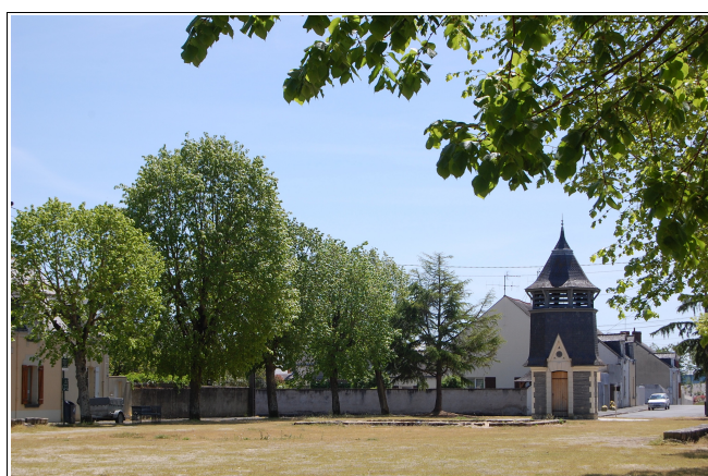
Illustration 17: Vue sur le château d'eau de la place
