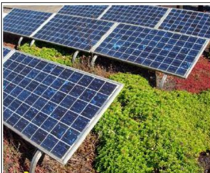
Photo 21 : Panneaux photovoltaïques inclinés. Source : Google Images.
