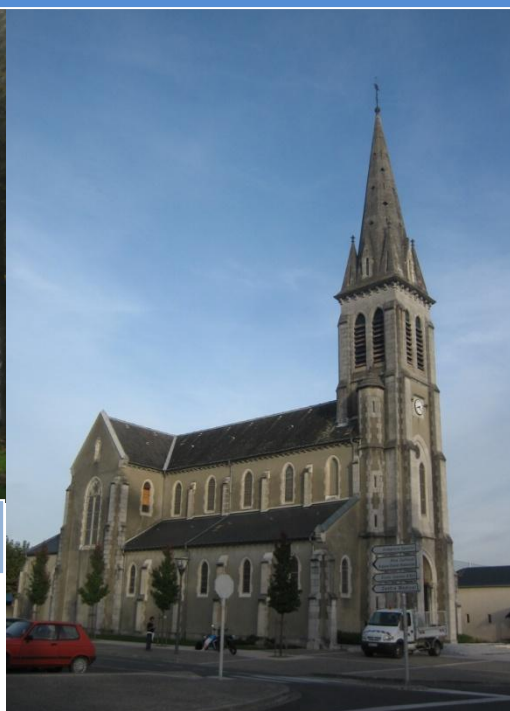
Photo 3 : Eglise (Photo personnelle)
