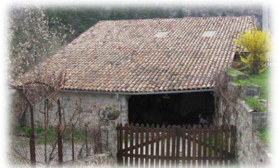
Figure 36: grange actuelle; photographie réalisée le 20.04.2010 par Marjory MARTINI
