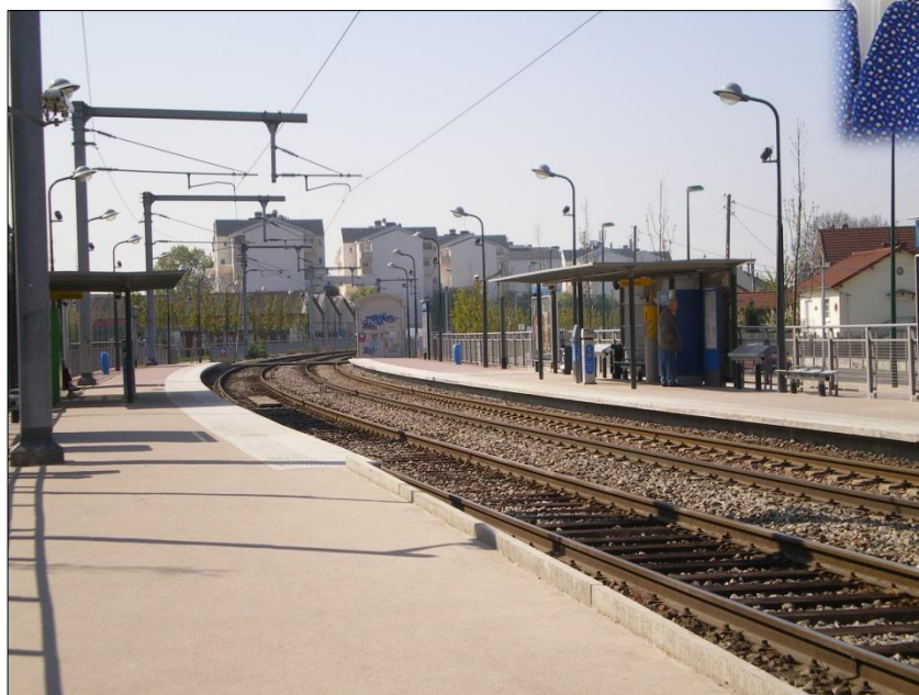
Figure 59: gare de Freinville Sevrans Source : réalisation personnelle Hélène Huet Avril 2010
