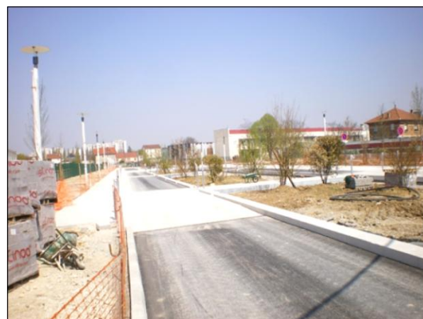
Figure 37: travaux Avril 2010 Source : réalisation personnelle Hélène Huet Avril 2010
