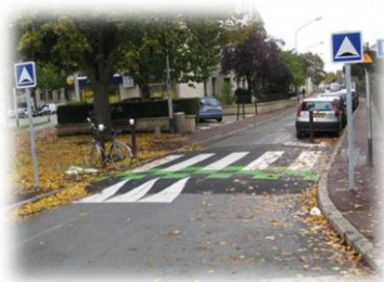
Figure 137: Passage piéton surélevé Source: www.hellopro.fr
