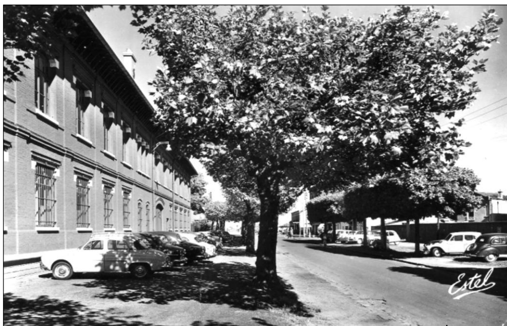
Figure 73: Le Boulevard Westinghouse dans les années 60 Sources : Pôle urbain de Sevrans
