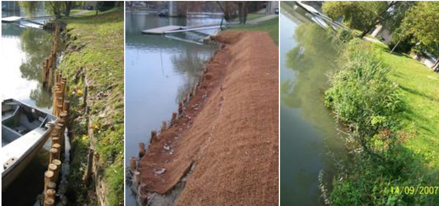
Photo 10: Berge effondrée au Beach de Saint Maur début 2005 - Application des techniques végétales fin 2005 - Renaturation 09/2007 © Syndicat Marne Vive
