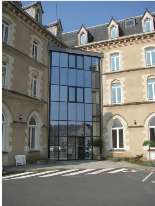
Figure 34 : Entrée de l'E.H.P.A.D. (Réalisée par A. GUIBOUX)
