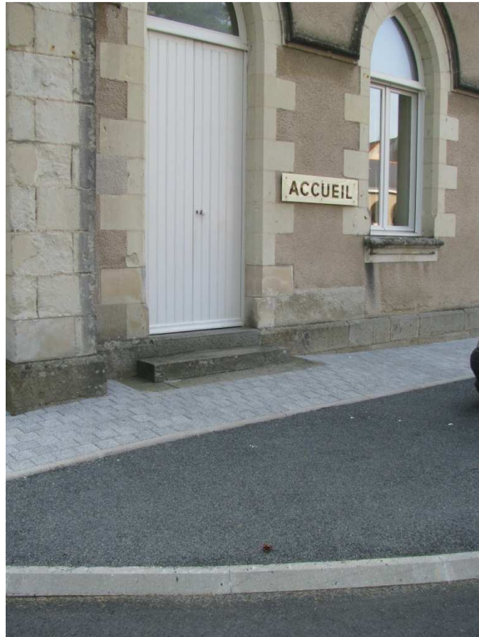
Figure 39 : Entrée principale de la Congrégation (Réalisée par A. GUIBOUX)
