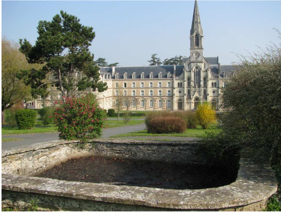
Figure 31 : Mare du parc sud (Réalisée par A. GUIBOUX)
