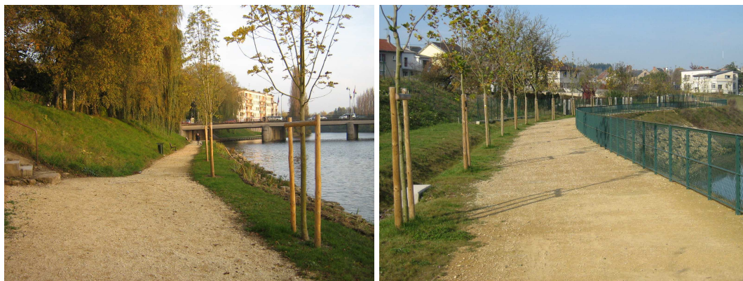
Photo 15 et 16 : Berges réaménagées
