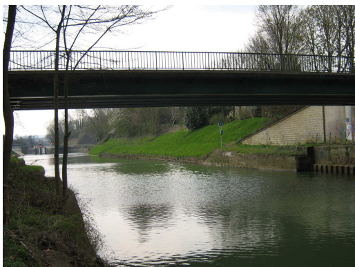
Photo 2 : Canal de l'Est
