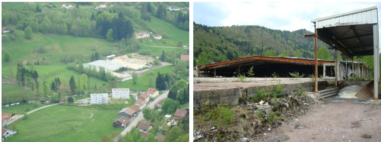
Figure 13 : Vue du site et état actuel des bâtiments en l'état (@GERARD Pauline)
