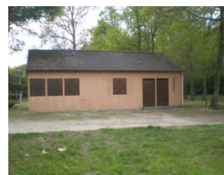
Figure 58: Bâtiment sanitaire de l'ancien camping
