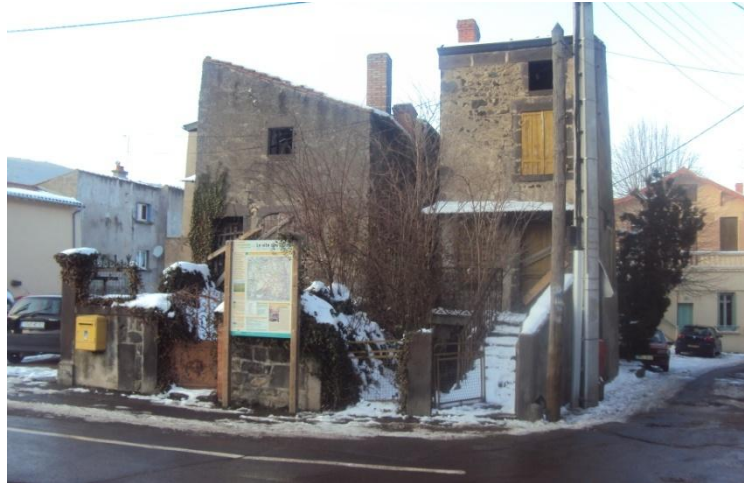
Photo 16 : Vieilles maisons détruites d'ici fin 2010.
