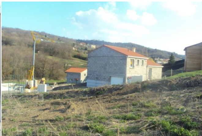
Photo 11 : Lotissement en construction à la périphérie nord est de la commune
