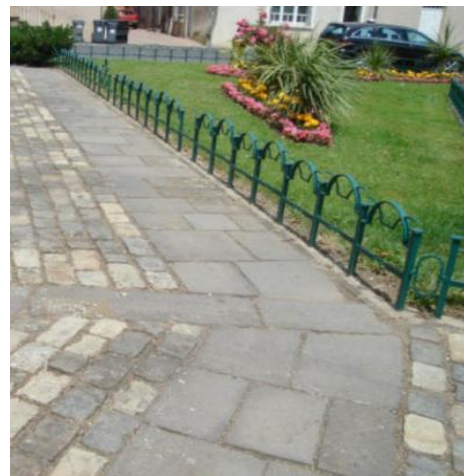
Photo 35 : Exemple de revêtement en pierre de Volvic à Issoire(63).
