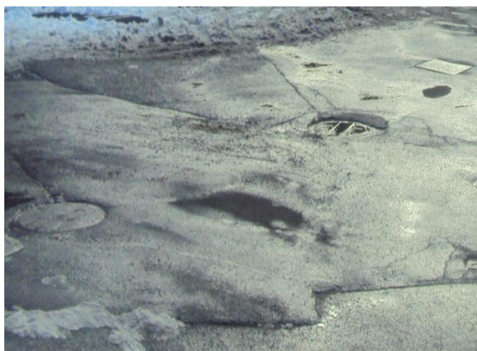
Photo 30 : Bouches d'égout au milieu de la place
