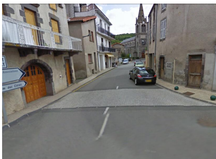
Photo 33 : Rue de la Barreyre et le stationnement « sauvage » au bord du trottoir
