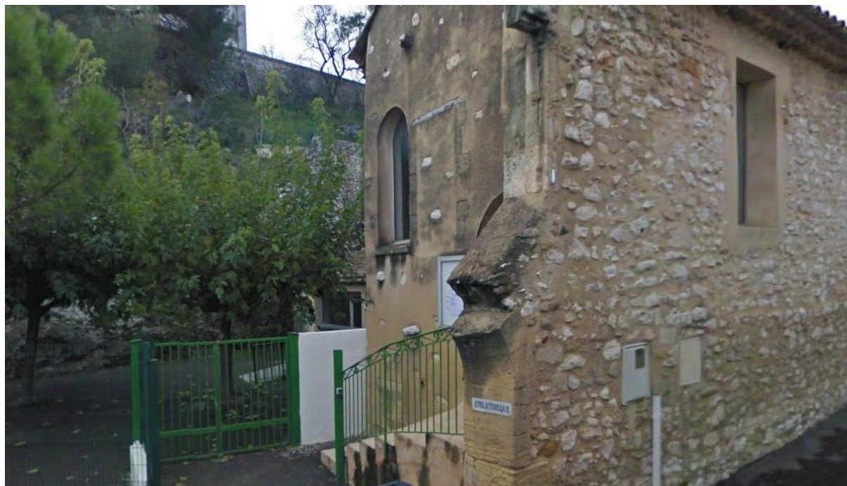
Figure 12 : Entrée de la bibliothèque. Source : Google Map street view.
