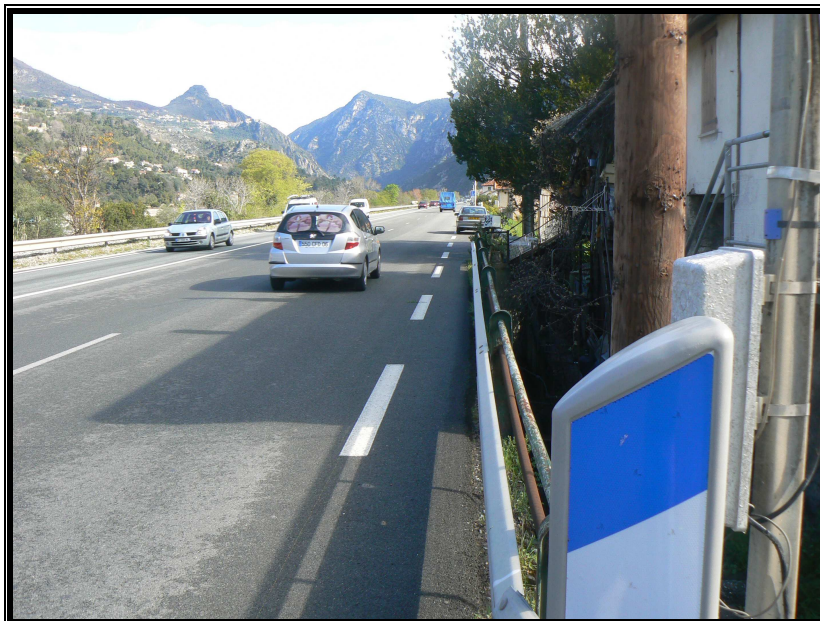
Photo 8 : Circulation de la route départementale RD 6202
