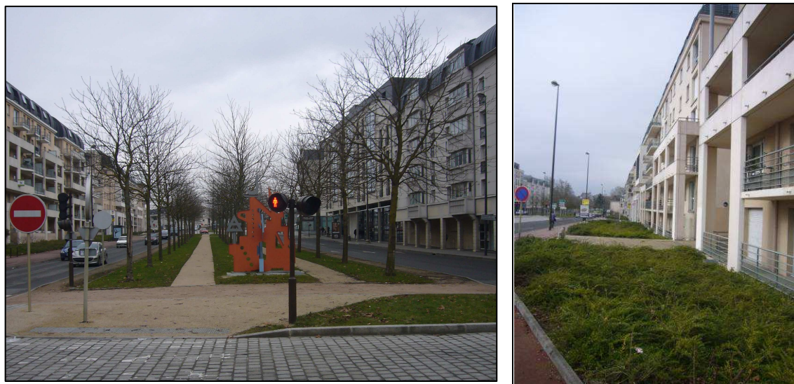
Photo 6 : Avenue Jean Zay au niveau de la ZAC de la Manufacture
