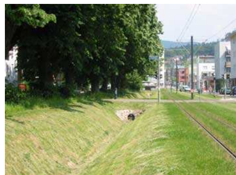
Figure 50: Fossé d'infiltration au quartier Vauban, Freiburg
