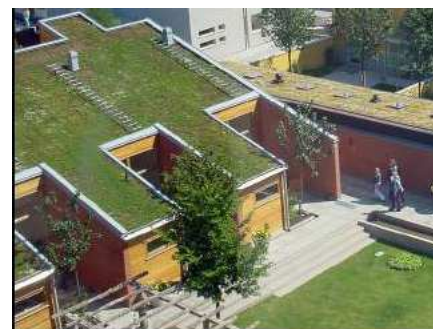
Figure 48: Toit vert dans le quartier BO01
