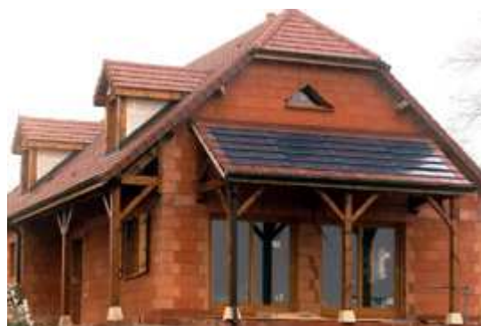
Figure 13: Le bâtiment en le brique de terre cuite 40
