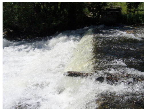
Première marche en haut du seuil (06.07.2010) Débit : 2,33 m 3 /s
