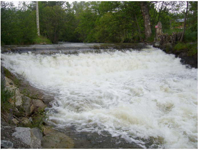
Vue générale du seuil en hautes eaux (22.06.2010) Débit : 2,25 m³/s
