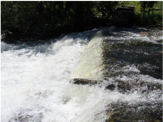
Première marche en haut du seuil (06.07.2010) Débit: 2,33 m³/s
