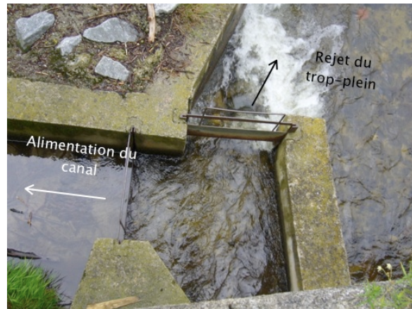
Figure 20 : Trop-plein du canal alimentant la passe à poissons (18.06.2010)
