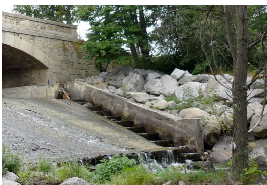
Figure 21 : Vue générale de la passe à poissons et coupe en long de celle-ci
