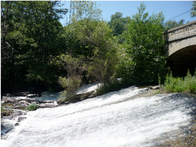
Vue du seuil à partir de la rive gauche (13.07.2010)
