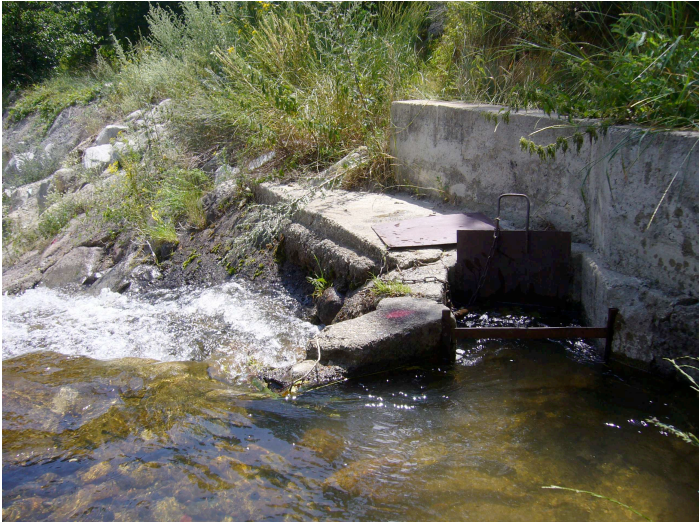
Prise d'eau du canal des Ansanères (21.07.2010)
