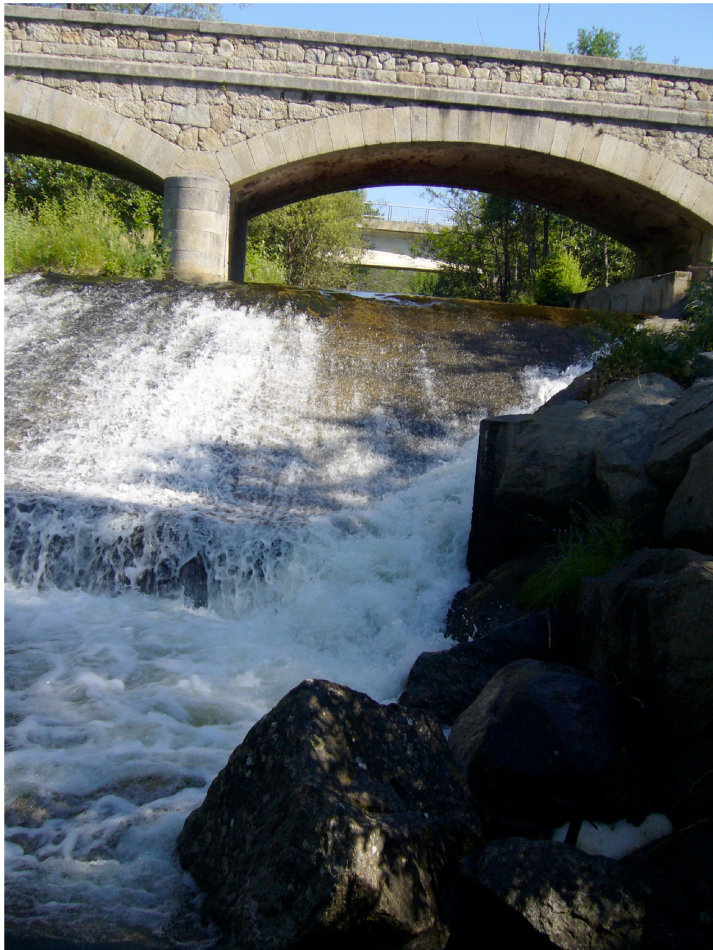
Vue du seuil en rive gauche, avec aval de la passe à poissons (19.07.2010)
