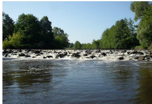
Figure 8 : Enrochement sur le Cher à Vaux
