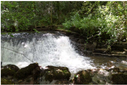
Figure 5 : Seuil du moulin de Chambon
