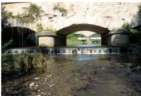
Figure 9 : Pont canal de Vaux
