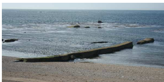
Figure 3 : extrémité aval du nô
