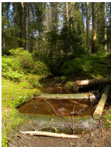
Figure 2 : Barrage en bois bloquant la circulation de l'eau d'un drain (Source : auteur)
