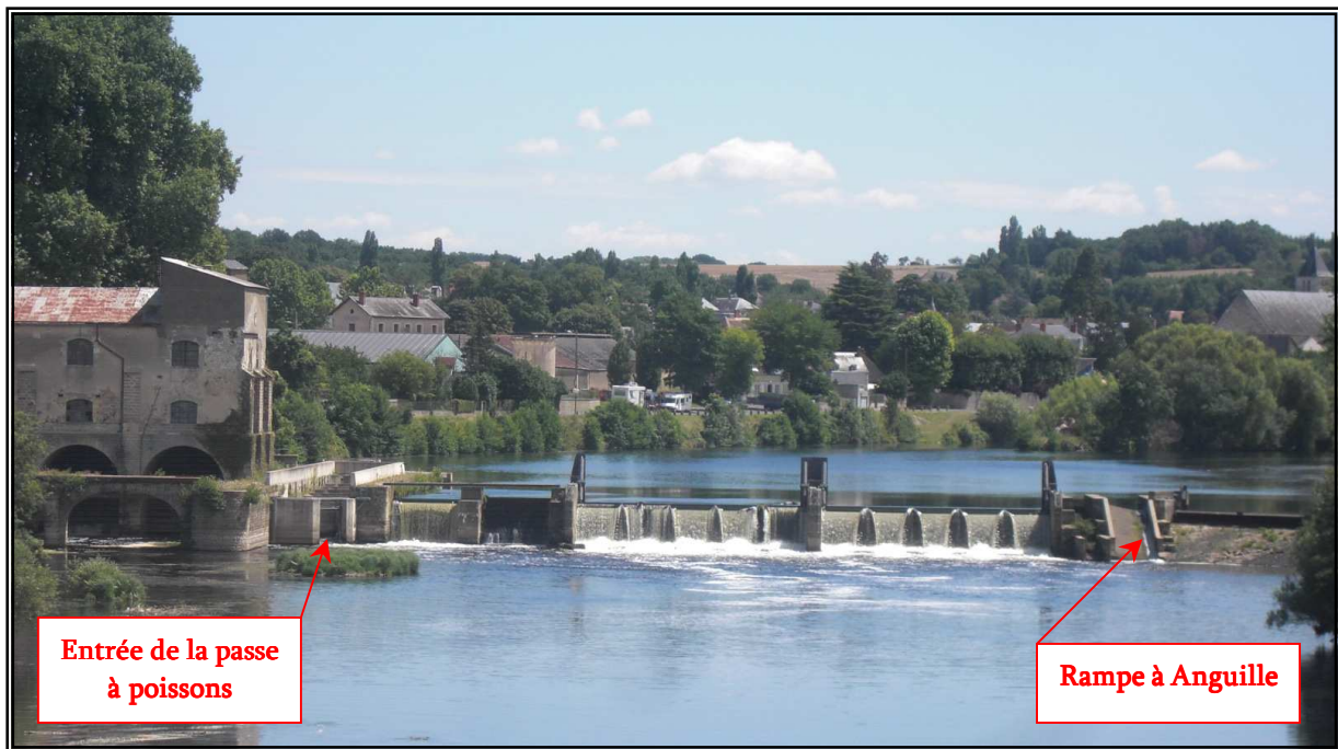
Figure 4 ; Photo prise de l'aval du barrage de Descartes
