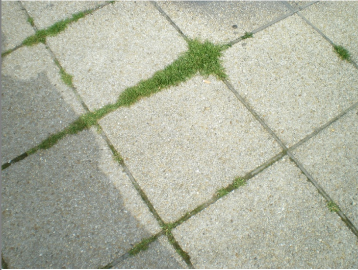
Figure 50 : Dalles autours des Halles, photo personnelle
