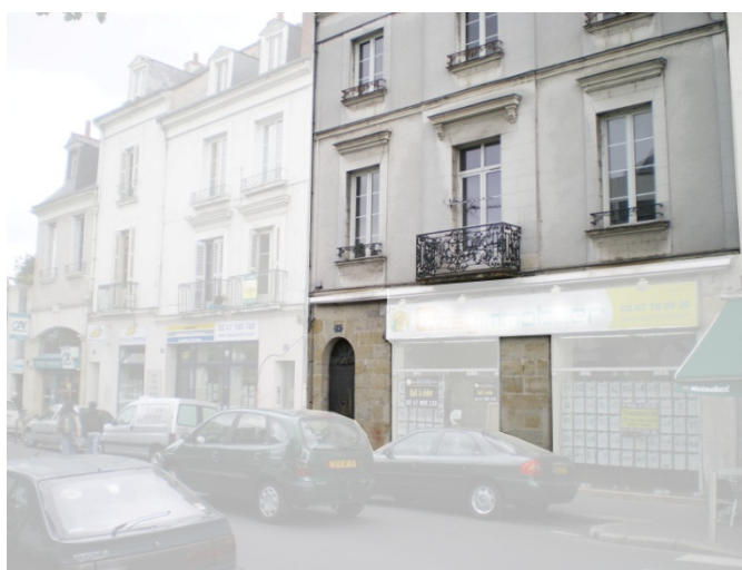
Figure 23 : Bâtiment ancien dans le quartier des Halles, photo personnelle
