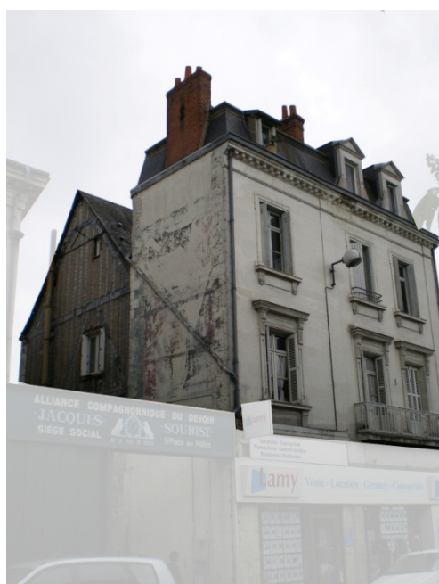
Figure 24 : Bâtiment ancien dans le quartier des Halles, photo personnelle
