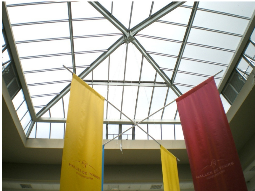
Figure 52 : Verrière du patio, photo personnelle
