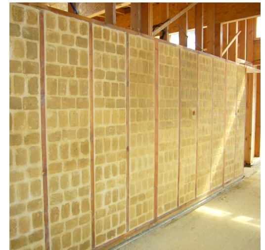
Image 14 murs intérieurs en brique en terre crue (source : Loïc Daubas, de Atelier Belenfant & Daubas)
