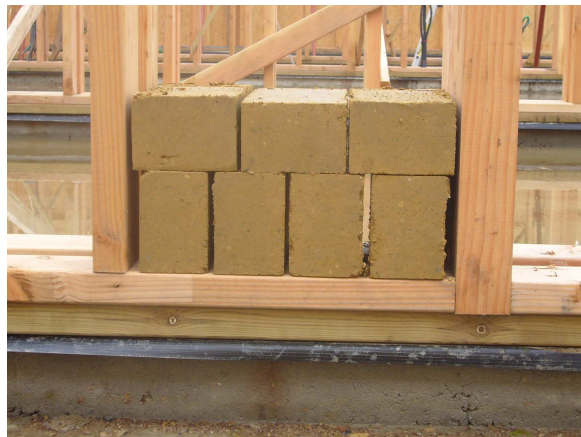
Image 13 brique en terre crue (source : conférence Loïc Daubas de Atelier Belenfant & Daubas)
