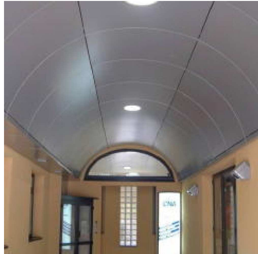
Image 15 Puits de lumière dans un couloir (source : internet)
