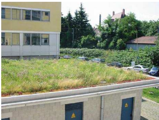
Image 17 toit végétalisé (source : google image)
