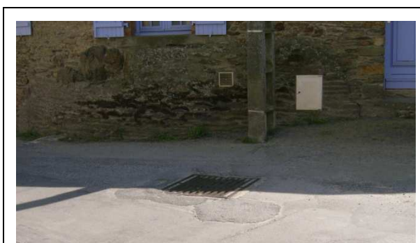
Photo 19 : Une des deux bouches d'évacuation sur la place
