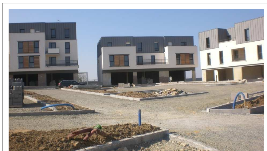
Photo 7 : Place en construction aujourd'hui
