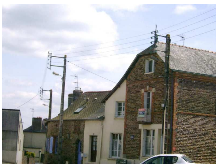
Photo 18 : Réseaux aériens trop voyants
