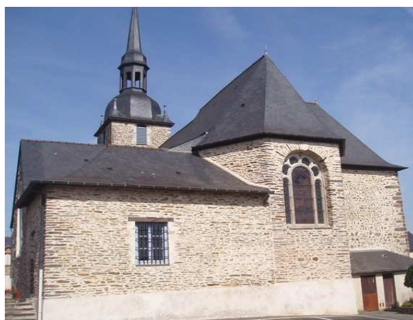
Photo 25 : Derrière l'église avant aménagement
