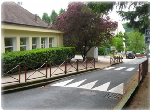
Image 25 : Vue en amont du dépose-minute
