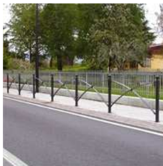
Image 21 : Barrière de protection
