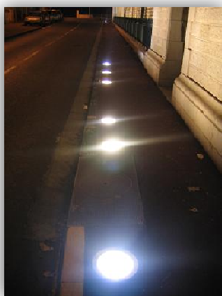
Image 52 : Système d'éclairage au sol
