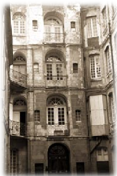
Image 6 : Cour Ovale avant les travaux
