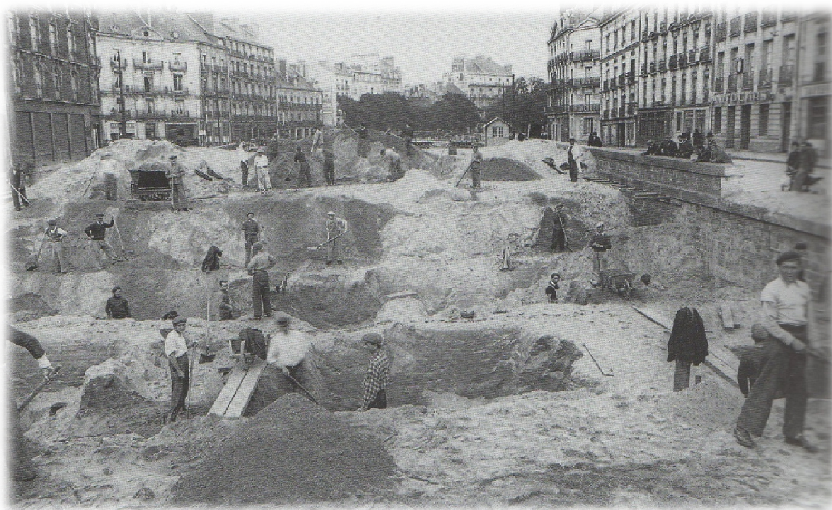
Image 21 : Chantier dans le lit de l'Erdre en octobre 1940
