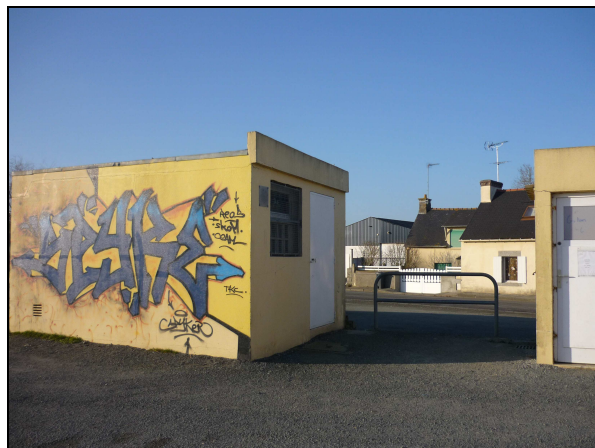
Photographie 14 : Le poste de relevage d'eau Source : photo personnelle
