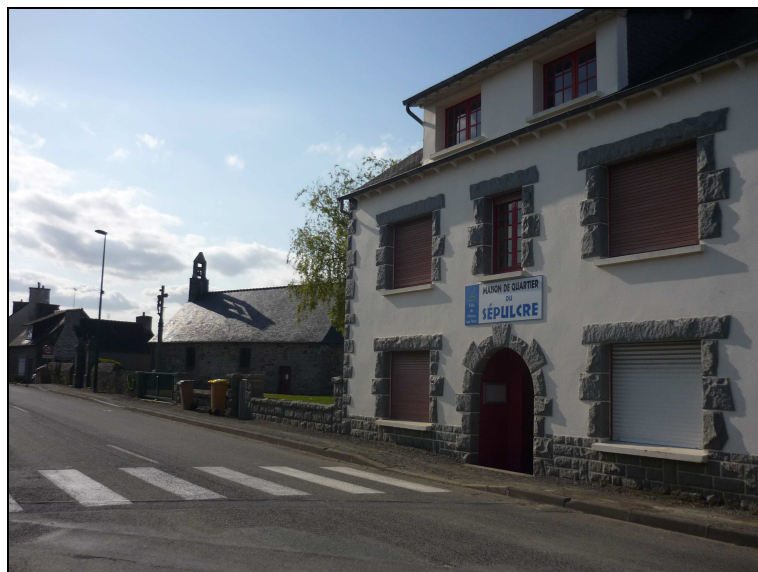
Photographie 5 : La maison de quartier
