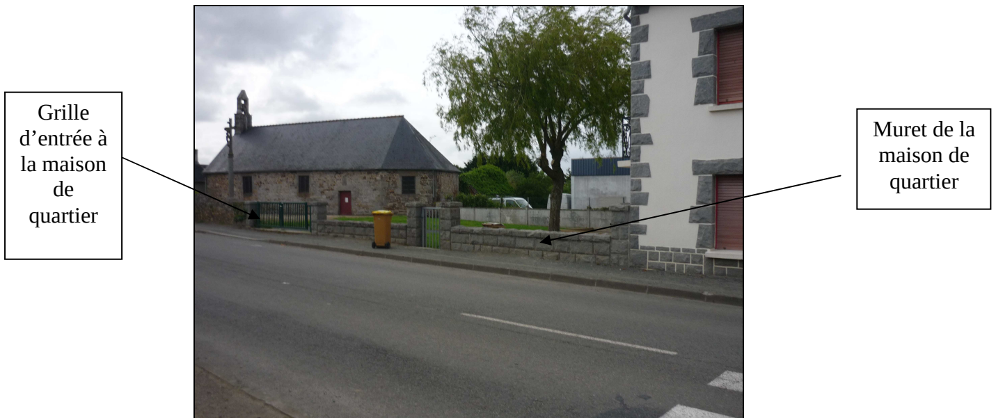
Photographie 34 : Grille d'entrée à la maison de quartier et muret donnant sur la rue Montesquieu Source : photo personnelle
