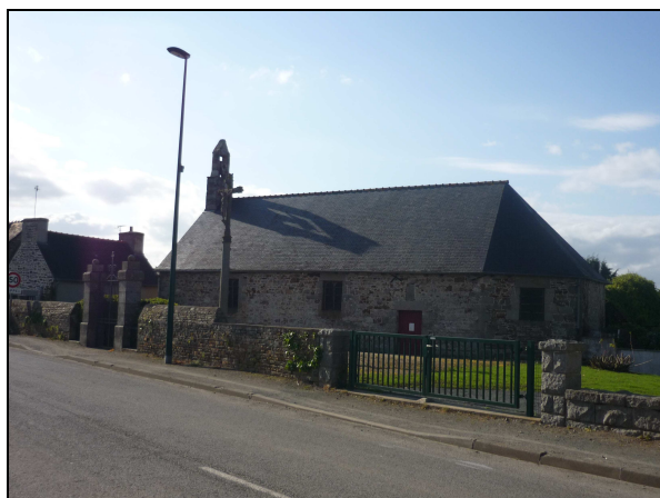
Photographie 23 : Grille et muret Source : photo personnelle
