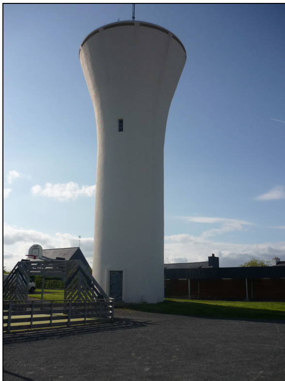
Photographie 11 : Le château d'eau Source : photo personnelle
