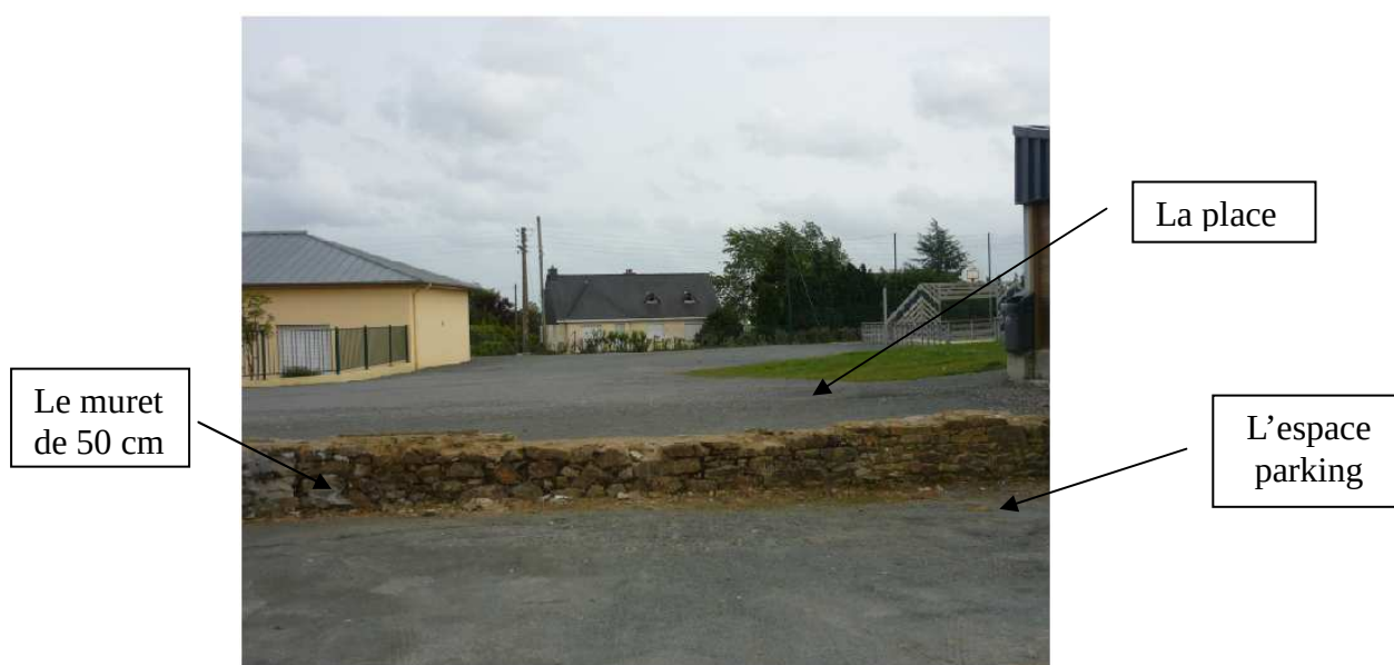
Photographie 27 : Espace de parking actuel
