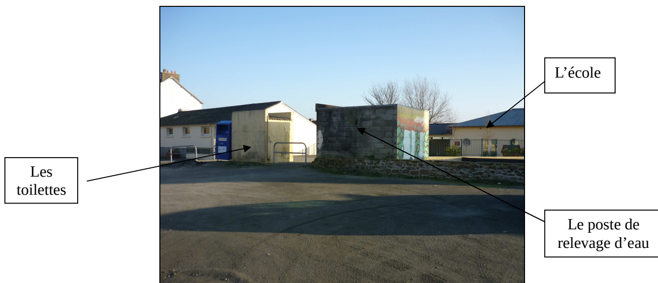
Photographie 12 : Les toilettes et le poste de relevage d'eau de la place Source : photo personnelle
