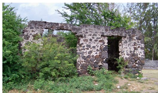
Illustration 30: Face nord de la ruine de l'ancienne cayenne
