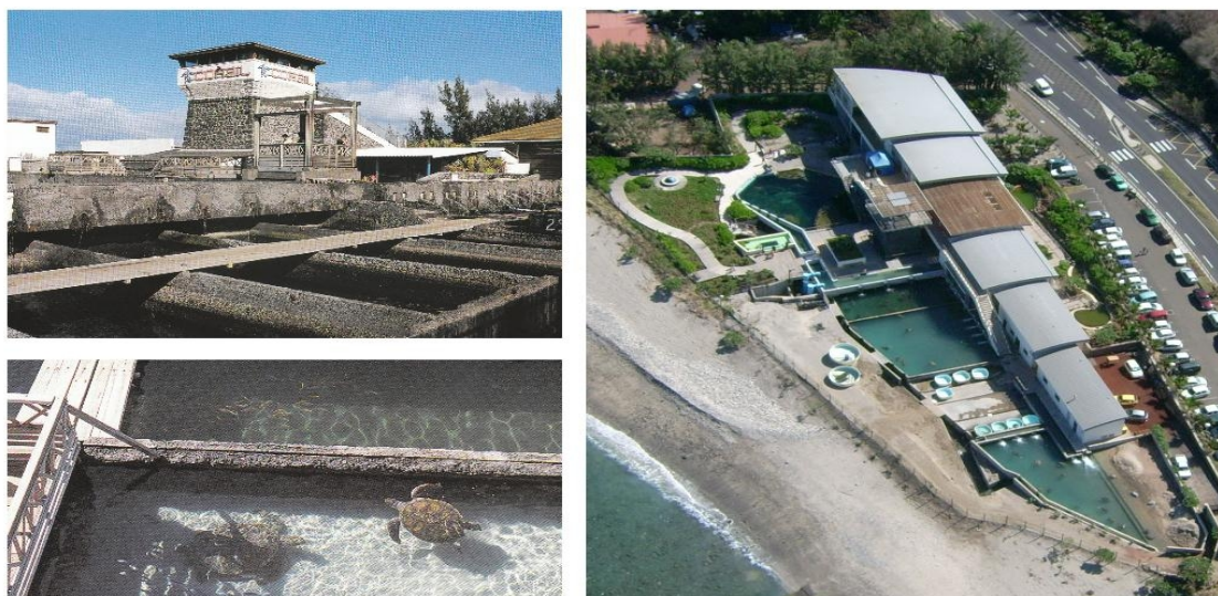
Illustration 29: Kelonia avant et après les travaux de 2006
