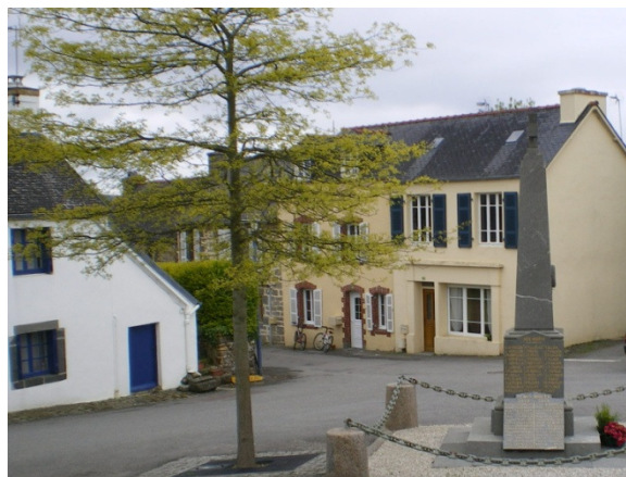
Photo 49 : Les façades du sud de la place (F), du côté de la rue de l'église
