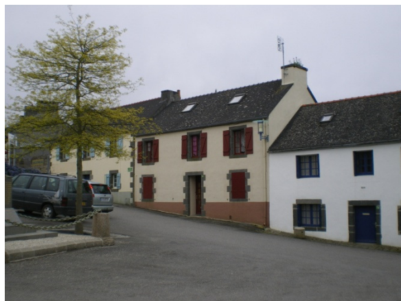
Photo 48 : Les maisons du sud de la place (E)
