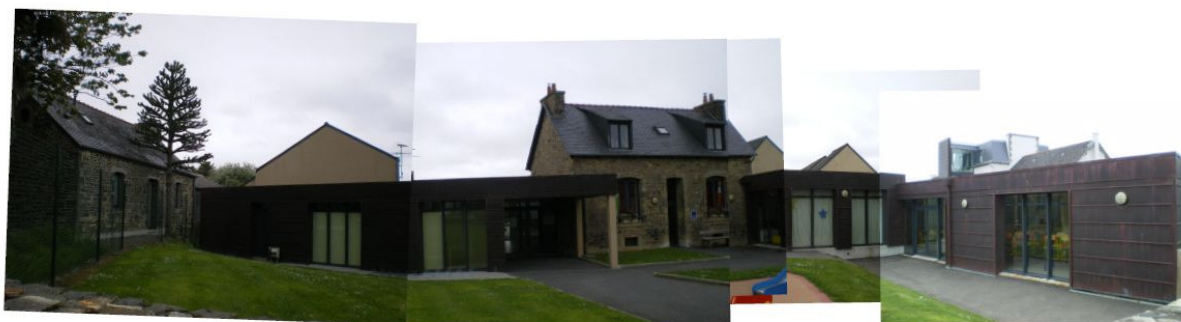
Photo 34 : L'école : le bâtiment de la garderie au milieu et la cantine à droite, depuis la place de la salle polyvalente
