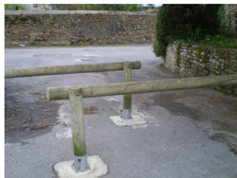
Photo 60 : Barrière en bois bloquant l'accès à la rue du patronage
