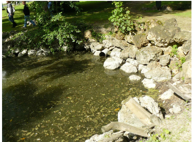
Photo 85: zone d'arrivée d'eau
