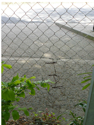
Photo 28 : grillage sectionné puis réparé
