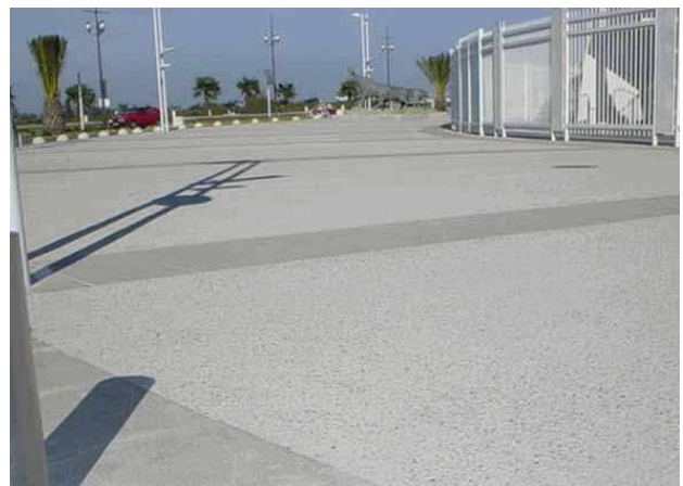
Photo 68 : exemple de revêtement en béton désactivé
