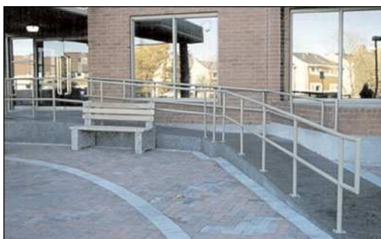
Photo 71 : exemple de rampe d'accès en béton
